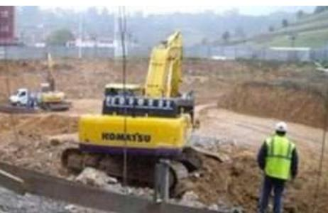
1. Correcta: El trabajador utiliza el chaleco reflectante de alta visibilidad en presencia de maquinaria.
