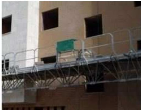
1. Correcta: Está nivelada, existe barandilla superior e intermedia, la superficie es suficientemente ancha.
