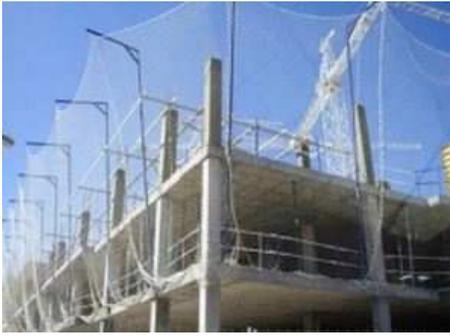
1. Correcta: Existe protección continua sin huecos entre las redes. La unión entre las redes es correcta. El borde superior de la red protege correctamente. La bolsa de recogida es de dimensiones apropiadas. La parte inferior de la red se encuentran limpias de materiales.
