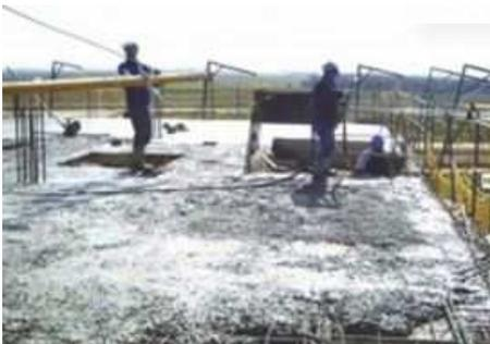
1. Correcta: Uso de botas de seguridad, altas e impermeables, uso de guantes impermeables, uso de gafas de protección anti proyecciones, uso de casco de protección de la cabeza.
