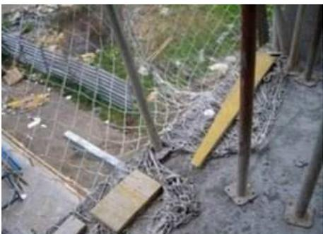
1. Correcta: Con las maderas se evitará el uso de clavos o piezas metálicas que podrían dañar el material de la red. El puntal no pisa la red por lo q no molestará al desmontaje.
