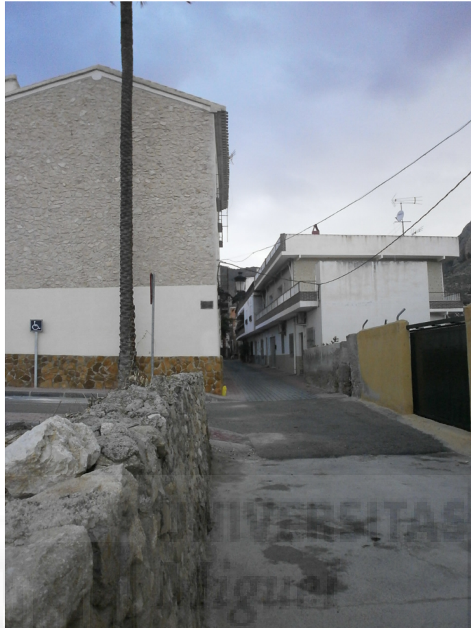
Calle Santiago (Solar a la izquierda)
