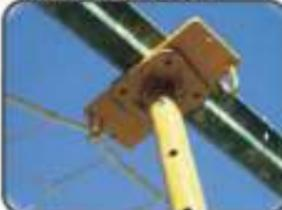
2. Montaje situando unas placas metálicas acopladas por debajo de la propia estructura del encofrado. Estas placas van provistas de unos ganchos a los que se incorporan los paños de red. Es necesario usar pértigas, pero la red queda anclada a la propia estructura
