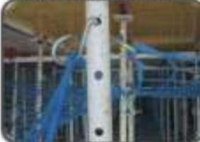
1. Montaje mediante unos ganchos de acero (de al menos 8 mm. de diámetro) sujetados los puntales del encofrado a una distancia no superior a 1 m del tablero. Se realiza desde el suelo.
