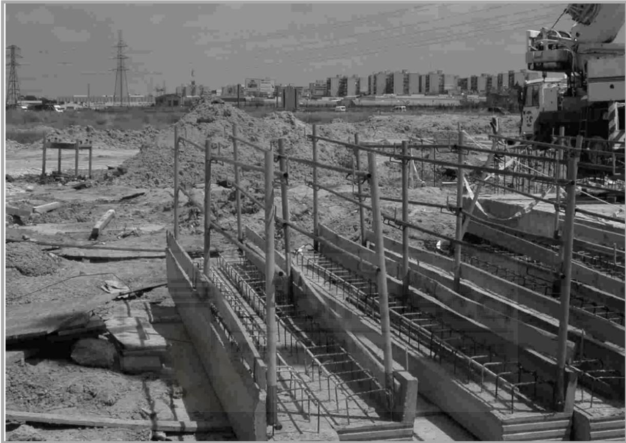
Figura 28. Ejemplo de barandilla integrada en el propio sistema de construcción
