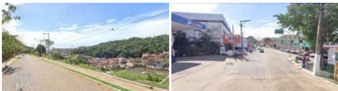
Figura 5. Carretera BA-654, acceso a Itacaré. Fuente: Google Maps.
