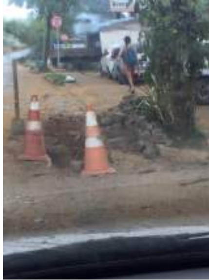
Figura 120. Agujero en la carretera. Fuente: Itacaré Urgente .
