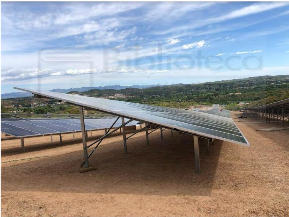
*Figura 4-Ejemplo de estructura hincada*
