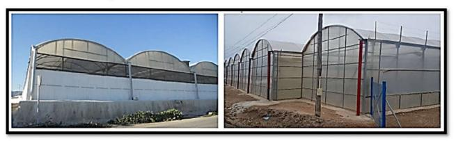
Se caracteriza por la forma de su cubierta y por su estructura totalmente metálica Son estructuras prefabricadas El montaje se realiza a modo de Mecano. Las diferentes partes se unen con grapas, tuercas y tornillos, por lo que no es necesario soldar.
