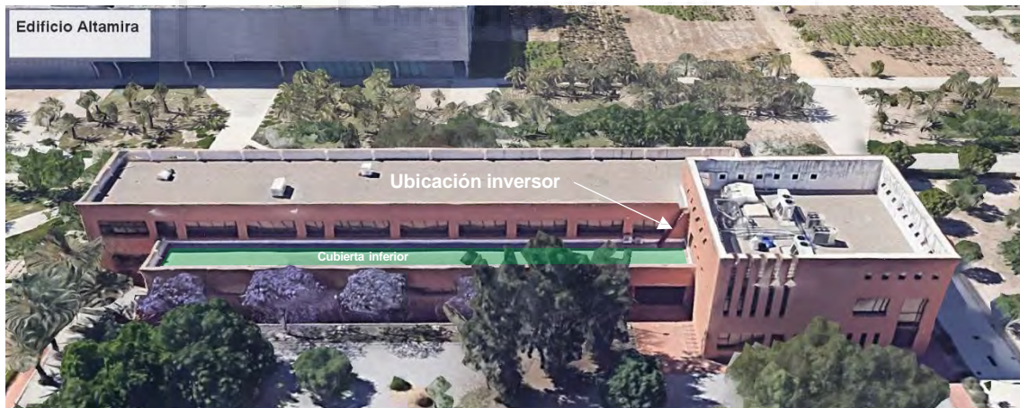
Figura 20. Ubicación inversor Edificio Altamira.
