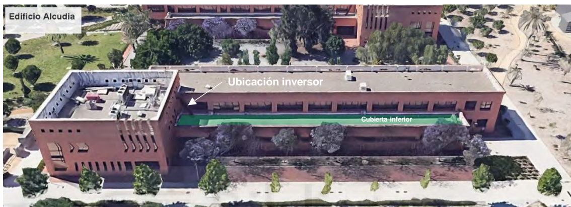
Figura 19. Ubicación inversor Edificio Alcudia.
