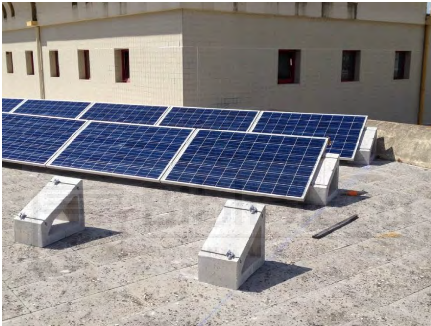
Figura 12. Método de instalación de soportes. Fuente: www.solarbloc.es
