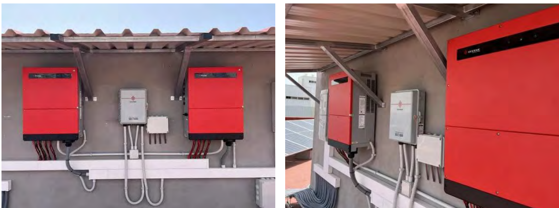
Figura 18. Detalle instalación inversor.
