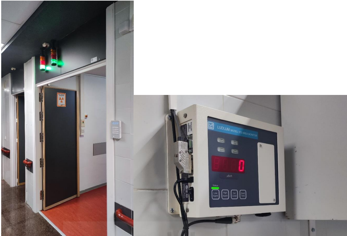
Figura 15. Señal luminosa verde y panel en cero, indican que no existe radiación en estos momentos.
