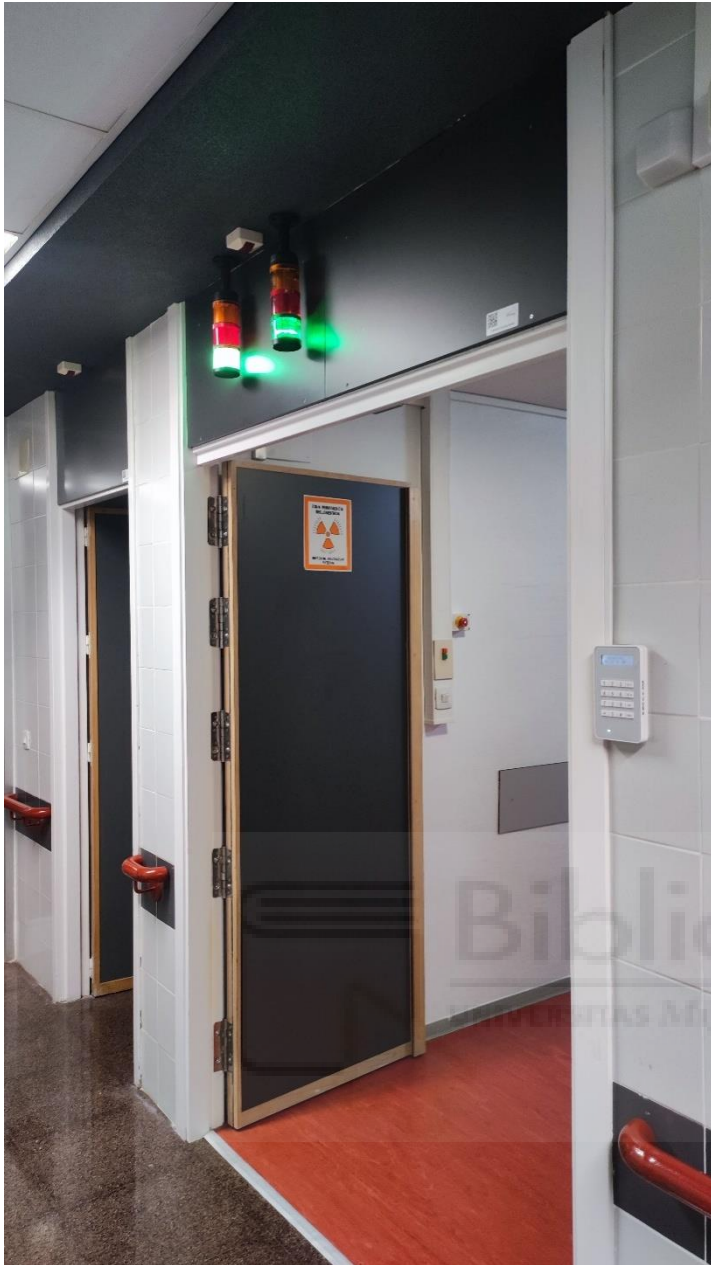
Figura 10. Búnker de braquiterapia mientras no se realiza un tratamiento, señalizado como zona controlada de permanencia reglamentaria, con trébol naranja.
