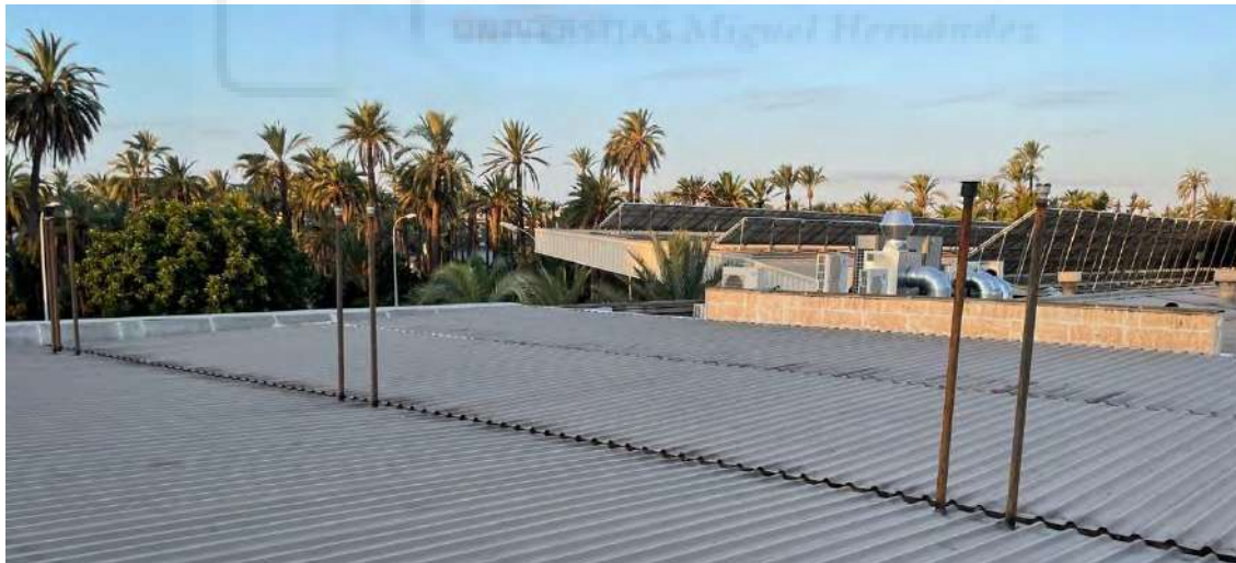
Ilustración 9: Balizas de extracción de gases y mureta.
