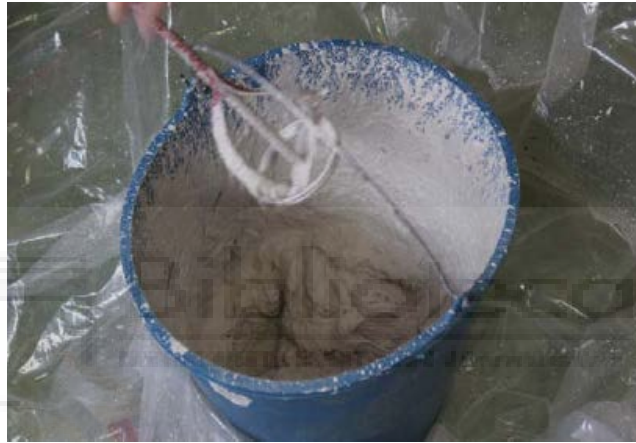
FOTOGRAFÍA 21: AMASADO DE MEZCLA
