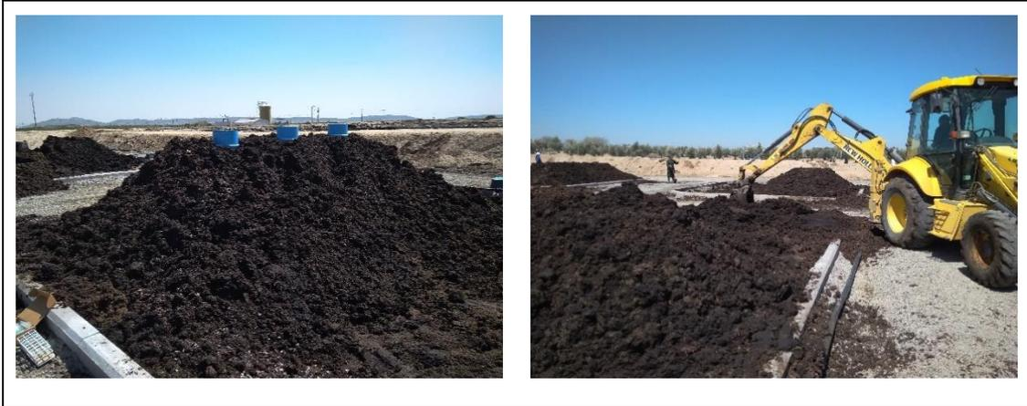
*Figura 3. Detalle de pilas de compostaje y volteo periódico mecánico.*
