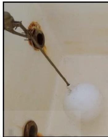
Imagen 2.21: Sensor de boya del depósito
