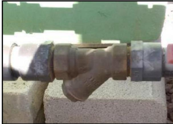
Imagen 2.25: Filtro de asiento circuito de calor
