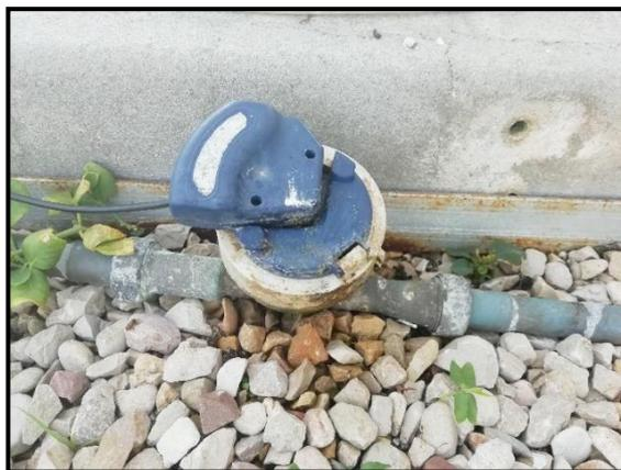
Imagen 2.22: Contador de pulsos del sistema
