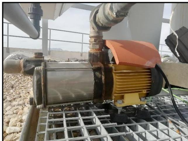
Imagen 2.38: Bomba hidráulica circuito de frío
