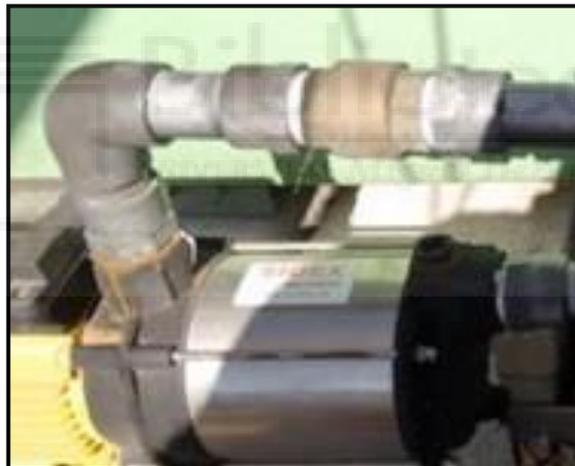
Imagen 2.26: Válvula de antirretorno del circuito de calor
