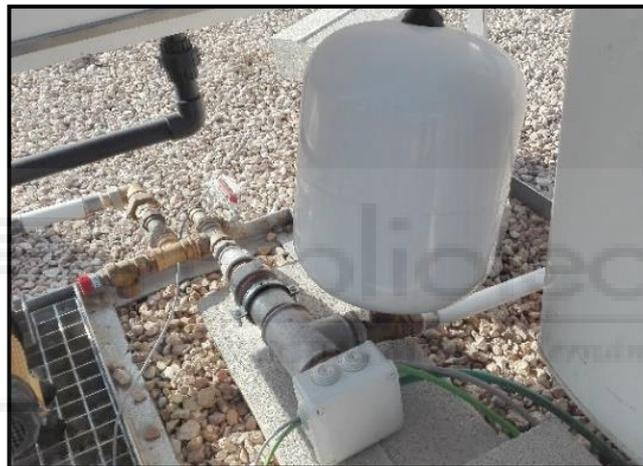
Imagen 2.35: Vaso de expansión instalado
