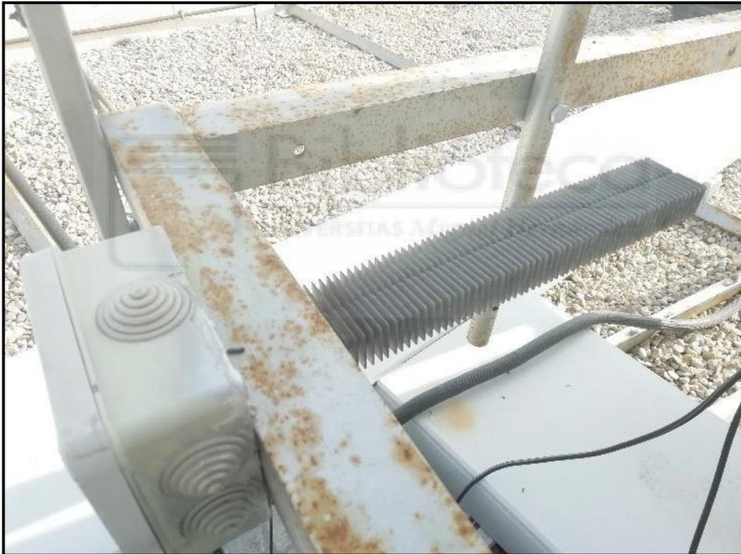
Imagen 2.40: Resistencia disipadora
