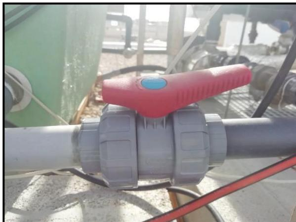
Imagen 2.19: Válvula de obturación situada en la aspiración de la bomba hidráulica
