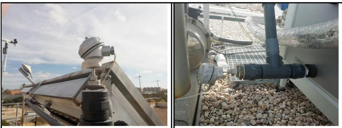
Imagen 2.7: Sensores de temperatura en la instalación; entrada y salida de chimenea
