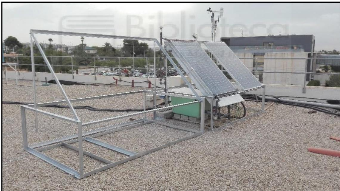
Imagen 2.1: Estructura de apoyo de los paneles
