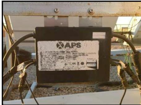
Imagen 2.27: Inversor de corriente de la instalación
