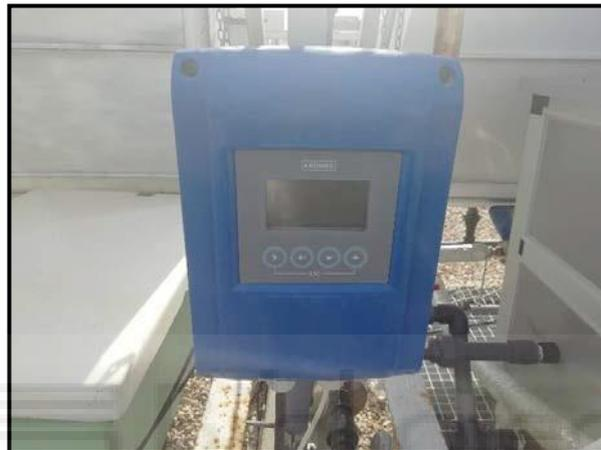
Imagen 2.4: Caudalímetro del circuito de calor
