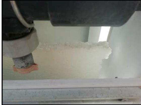
Imagen 2.18: Capa de corcho en el interior de la chimenea evaporativa
