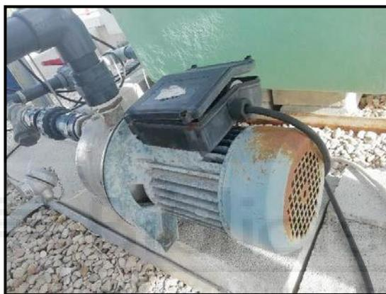
Imagen 2.23: Bomba hidráulica circuito de calor
