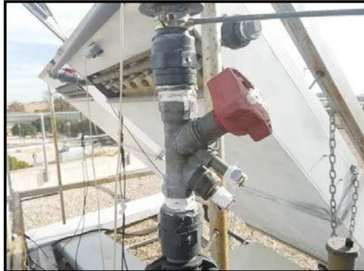
Imagen 2.6: Válvula de equilibrio circuito de calor
