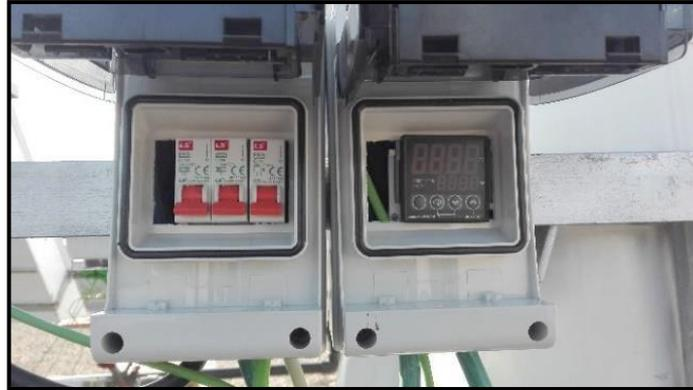
Imagen 2.37: Accionamiento de la resistencia eléctrica
