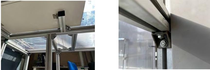
*Figura 3. 9 Detalles del anclaje de la mesa auxiliar.*
