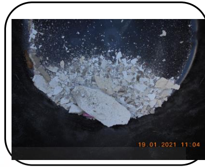
Restos de obras
