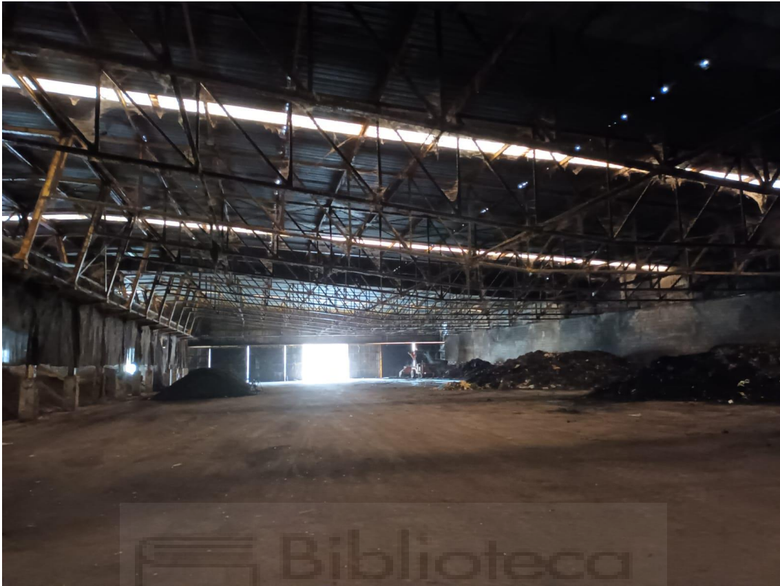
Imagen 16: Interior Planta de Compostaje del Complejo Ambiental de Tenerife
