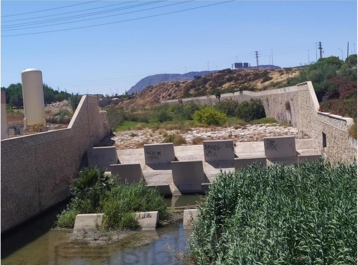
*Figura 19. Salto hidráulico situado en el tramo final del Barranco de las Ovejas.*
