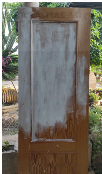
Fig.10. Imagen de la puerta siendo pintada de blanco.
