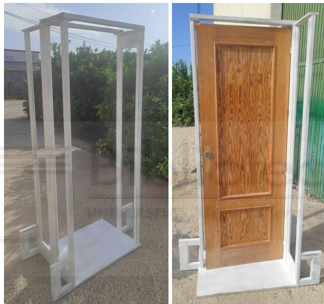
Fig.11. Imágenes del montaje de la puerta.
