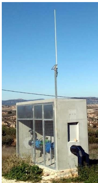
Figura 18. Hub de radio GPRS (arqueta de sectorización).
