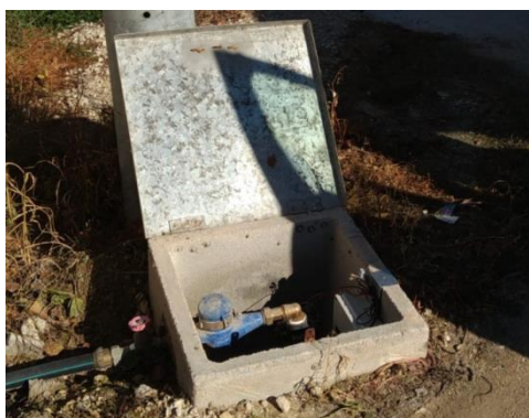
Figura 19. El hidrante instalado en una arqueta semienterrada.
