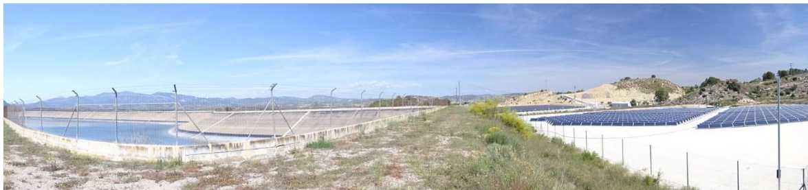
Figura 27. Instalaciones de Embalses y Solares. Fuente: Propio.
