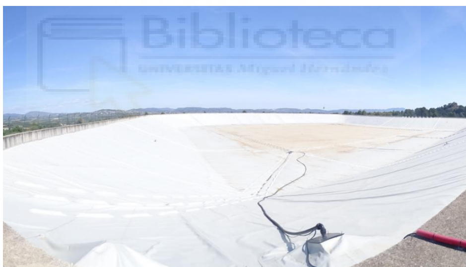
Figura 30. Lámina impermeable en el depósito para reducir la evaporación. Fuente: Propio.
