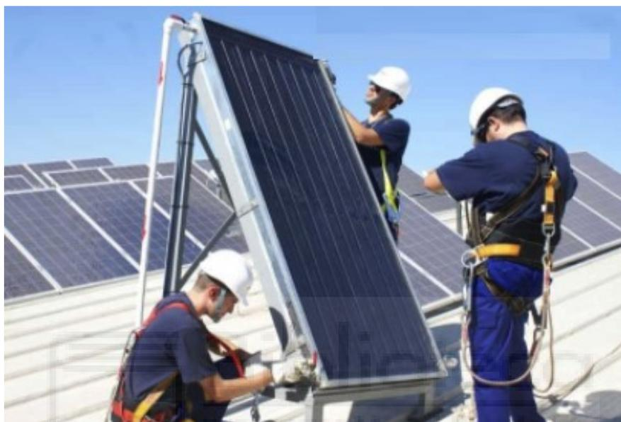
Figura 78 – Instalación captadores solares térmicos.
