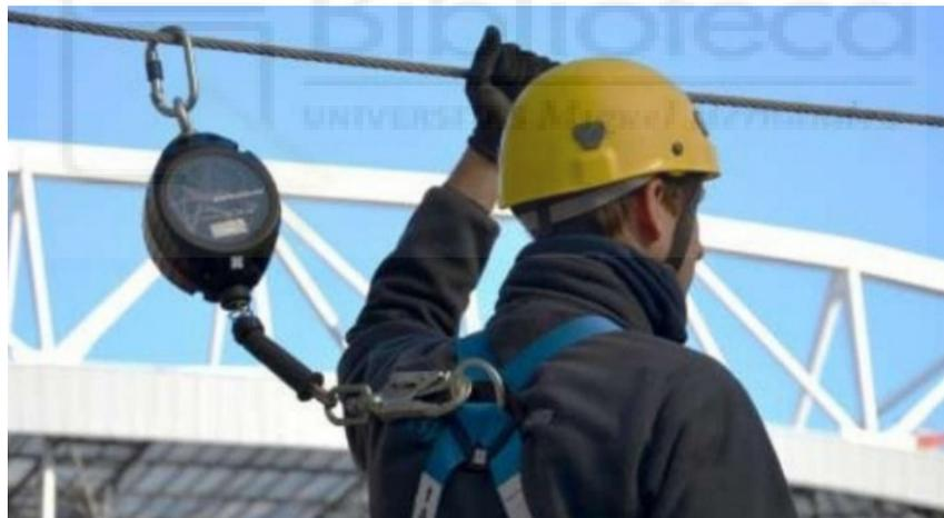
Figura 45 - Sistema anticaídas retráctil.
