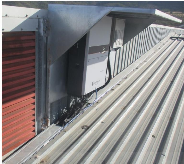
Figura 10 – Inversor ubicado en la cubierta.
