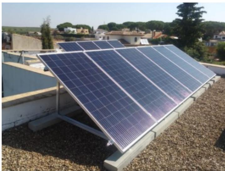
Figura 74 – Ejemplo de estructura inclinada con contrapesos.
