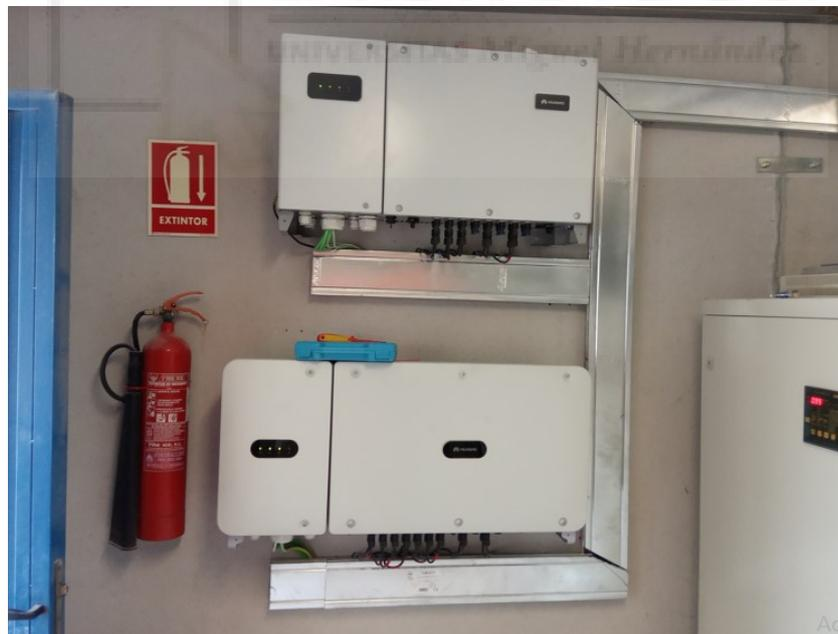
Figura 11 – Inversor ubicado en el interior de un cuarto de cuadros eléctricos.
