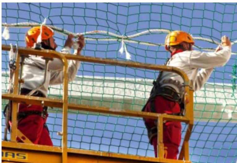
Figura 62 – Montaje anticaídas red.
