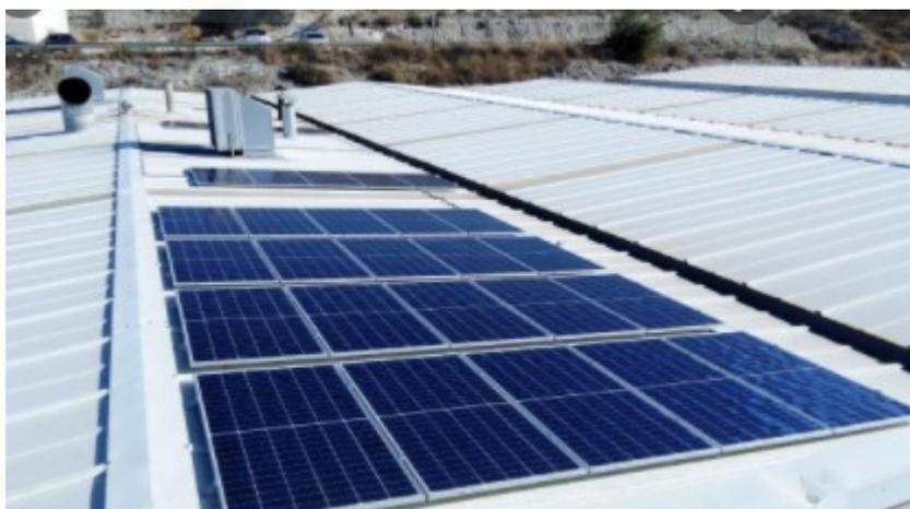
Figura 73 – Ejemplo de estructura coplanar.
