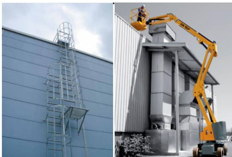
Figura 59 – Escalera fija de acceso a cubierta, y elemento de acceso móvil compuesto por plataforma elevadora articulada.
