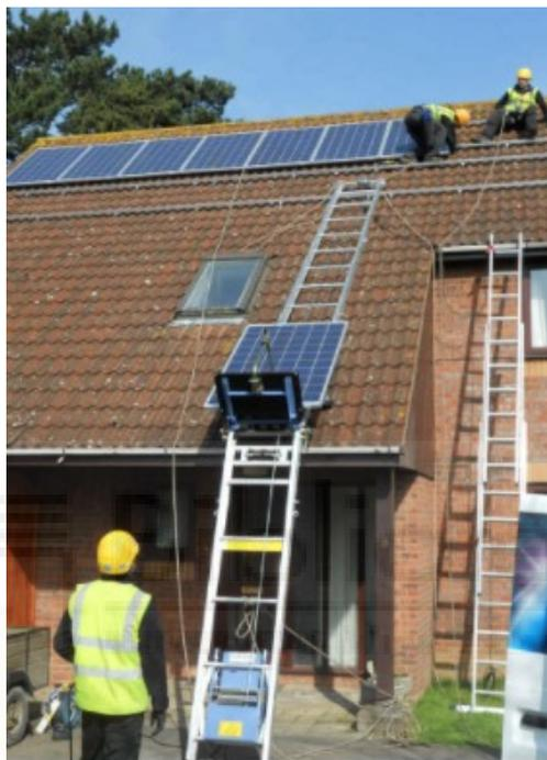
Figura 28 – Imagen de subida de material a cubierta.
