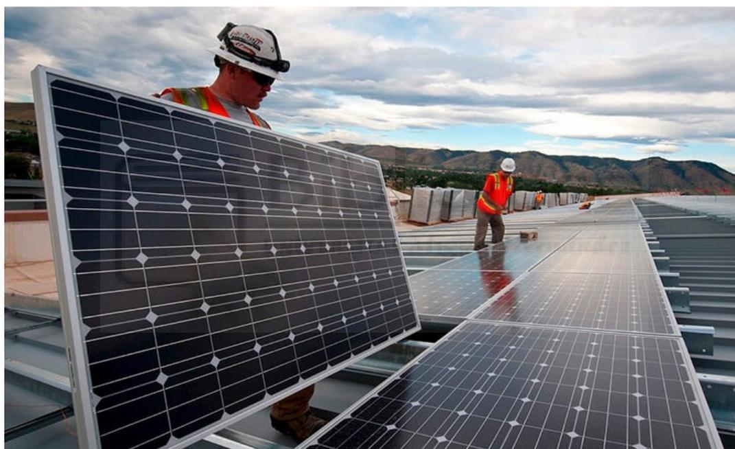
Figura 75 – Instalación de paneles solares.
