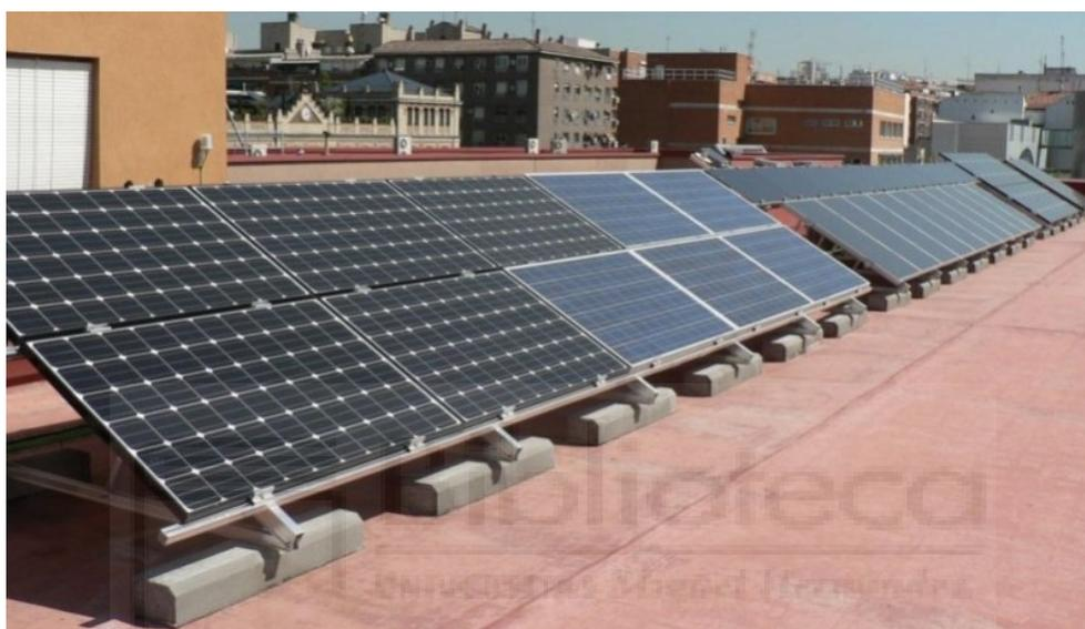
Figura 25 – Instalación solar fotovoltaica en cubierta plana transitable..
