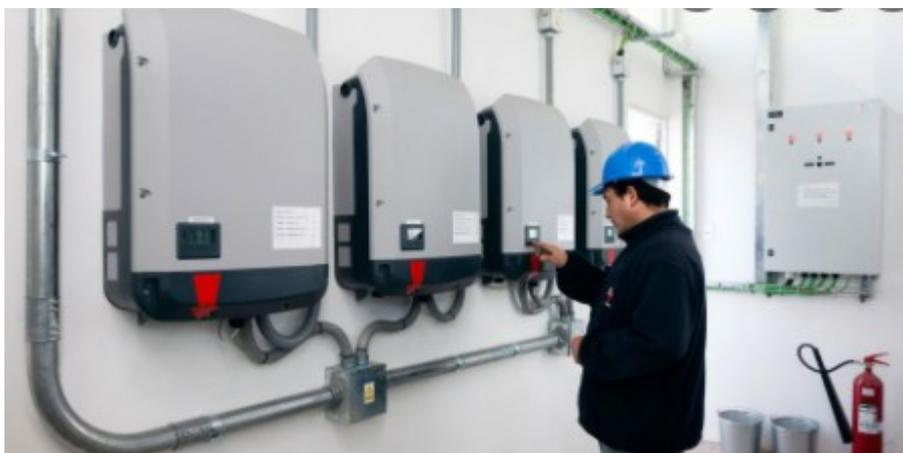
Figura 77 – Sala de equipos eléctricos, con inversores y cuadros de protecciones.
