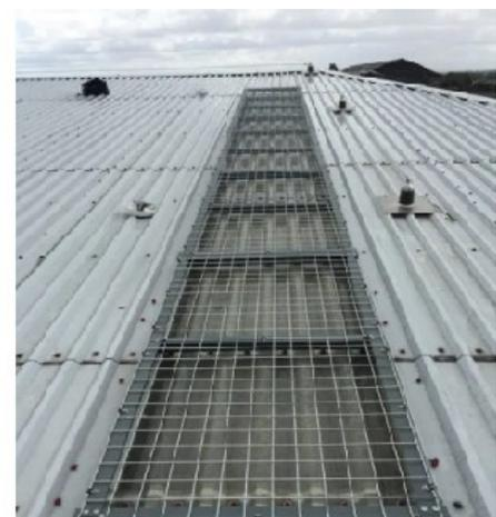
Figura 38 - Pasarela para cubiertas. Fuente NTP 448.
