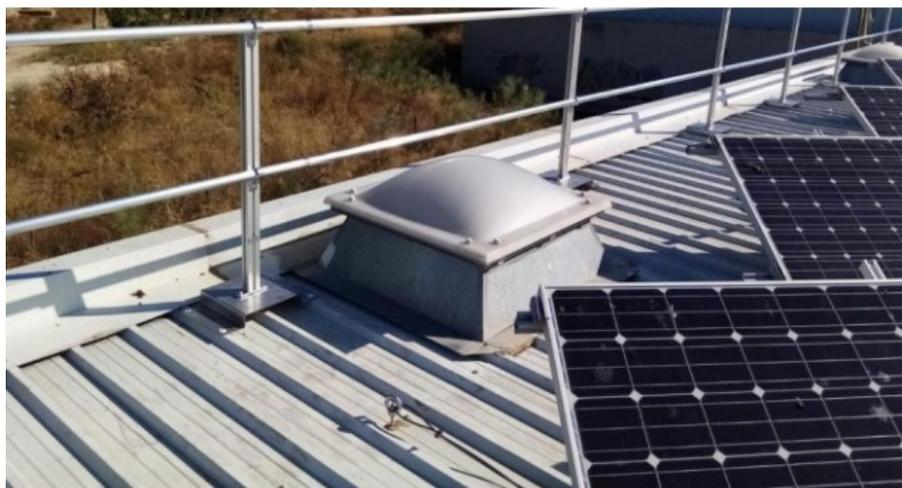
Figura 29 - Barandilla instalada en cubierta fotovoltaica.
