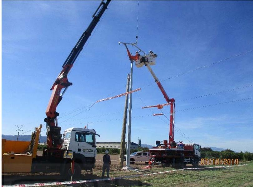
IMAGEN 9: Colocación del apoyo.
