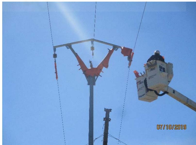
IMAGEN 12: Instalación de todos los conductores.
