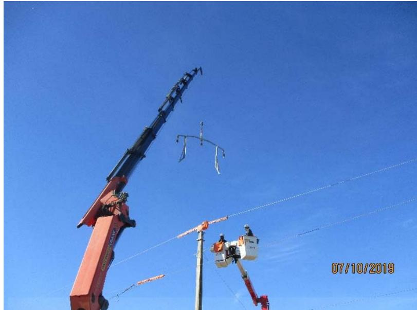
IMAGEN 6: Desmontaje de armado.
