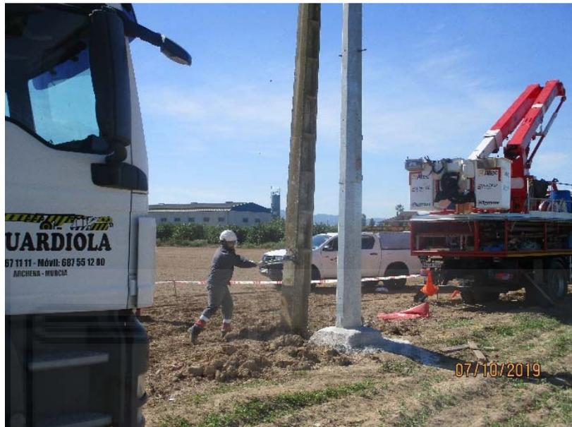
IMAGEN 14: Demolición del hormigón del apoyo existente.
