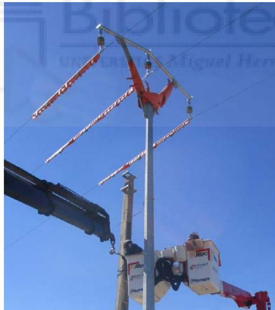
IMAGEN 13: Asegurado de apoyo a desmontar.
