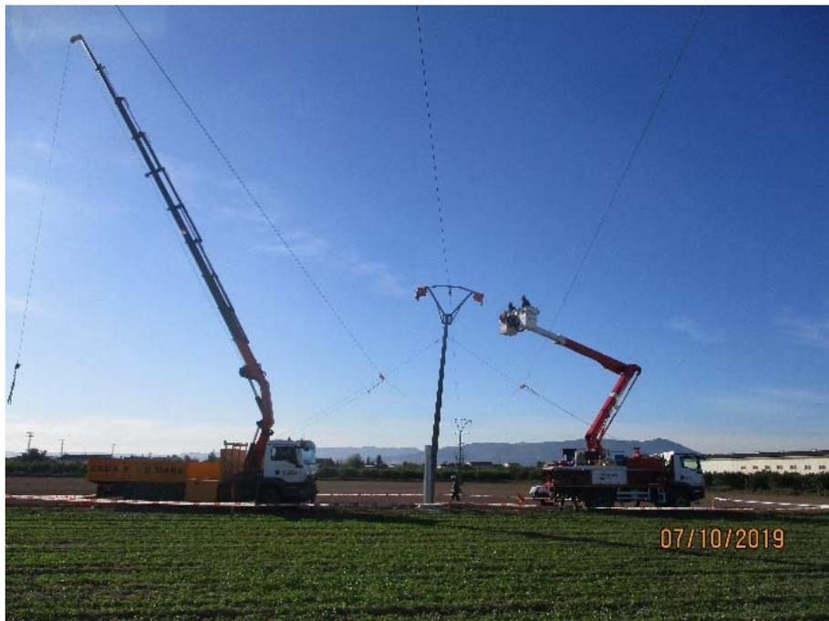
IMAGEN 5: Apoyo existente y desvío de conductores laterales.
