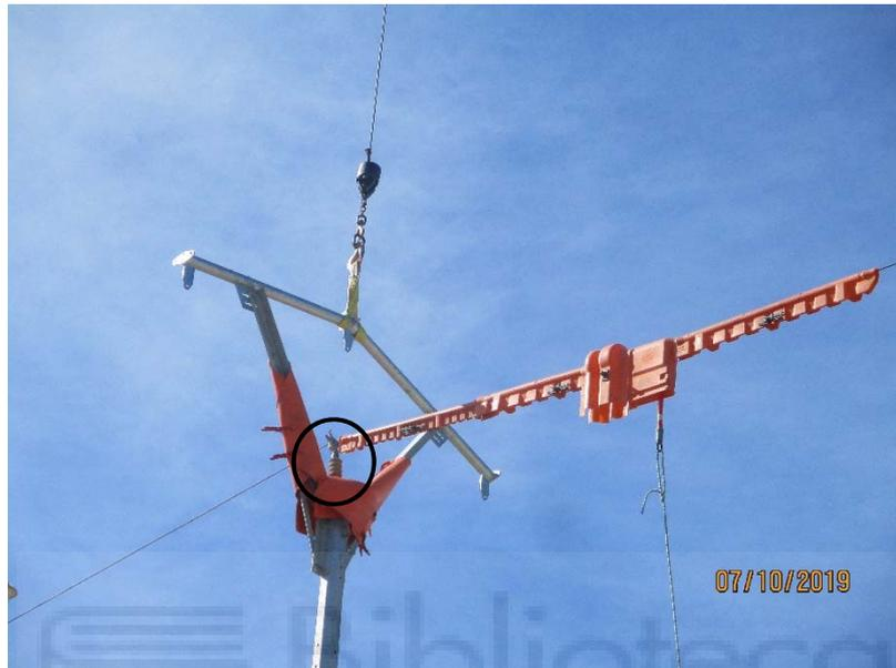
IMAGEN 11: Detalle de aislador rígido para conductor central en fase de ejecución de obra.
