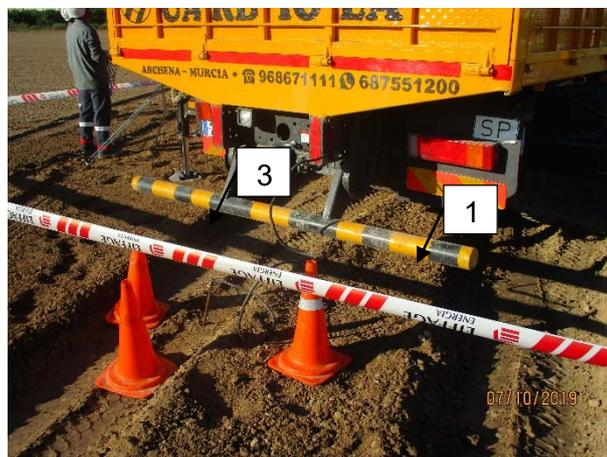
IMAGEN 4: Detalle de puesta a tierra del camión grúa.
