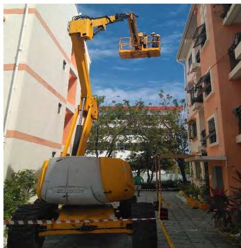
Imagen 6. Ejemplo de maquinaria para trabajo sin acceso a cubierta, debidamente señalizada
