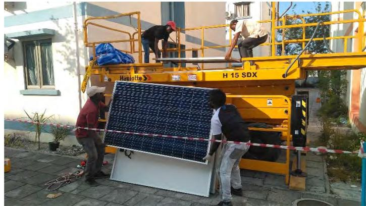
Imagen 34. Ejemplo de manipulación y elevación de material en condiciones de seguridad
