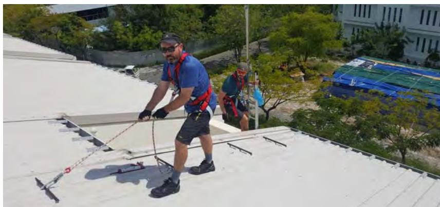
Imagen 28. Sistema de seguridad previo instalado antes del sistema de protección definitivo
