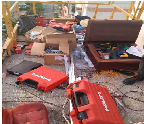
Imagen 35. Desorden que puede provocar accidentes por golpes, cortes, o caídas de material al vacío.
