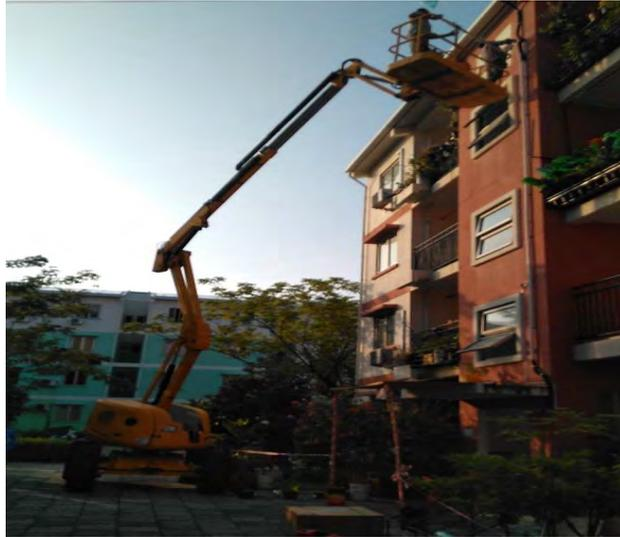
Imagen 33. Maquinaria en la vía pública sin la correcta señalización ni barrera material
