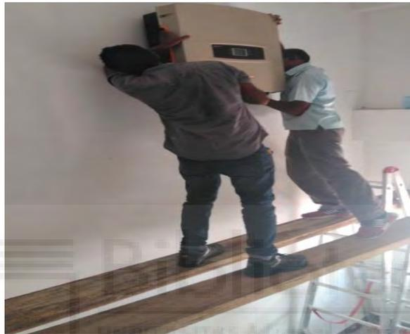
Imagen 22. Trabajo en altura en el que no se cumplen las medidas preventivas ni se usan los medios de protección adecuados.
