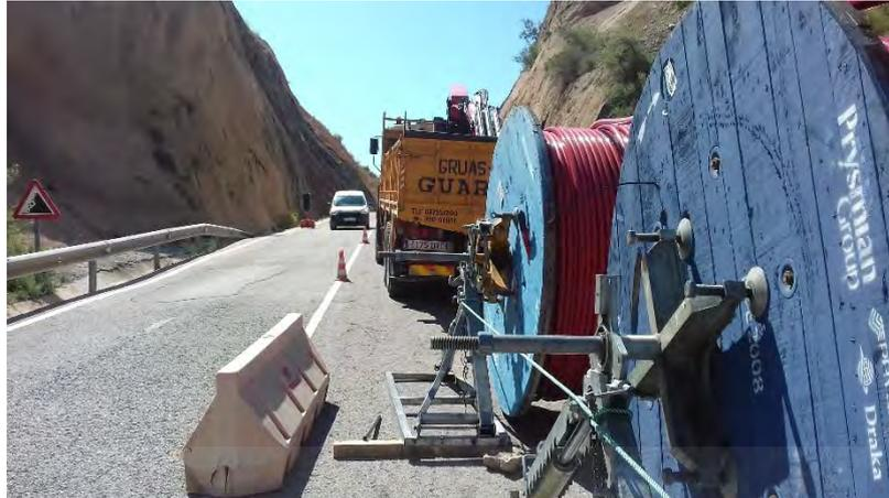
Imagen 38. Bobinas para tendido debidamente colocadas y señalizadas
