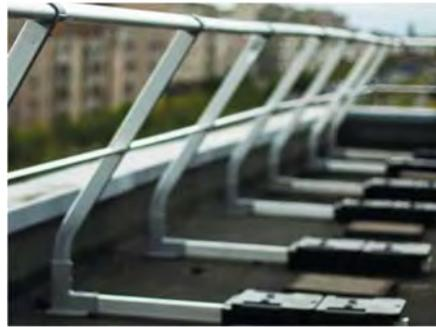
Imagen xx. Barandilla de protección en cubiertas transitables
