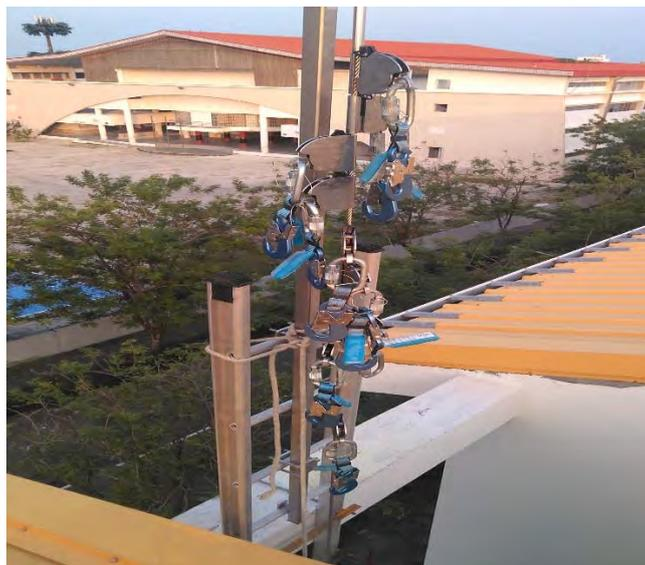
Imagen 30. Dispositivo de frenada de caída en escaleras
