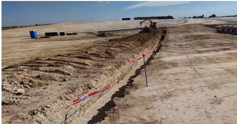
Imagen 16. Ejemplo de zanja señalizada y con elemento de barrera para impedir su acceso accidental
