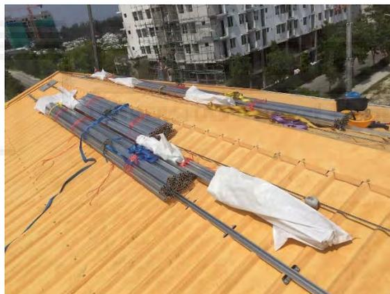
Imagen 36. Sujeción de perfiles en el tejado. Los extremos están protegidos para evitar salidas de perfiles y caídas.
