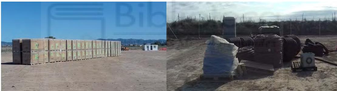
Imagen 10. Ejemplo de acopio correcto (izquierda) y ejemplo de acopio incorrecto (derecha).
