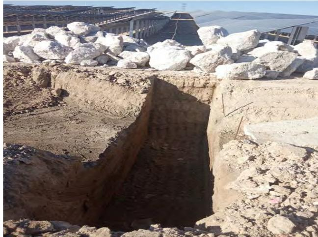
Imagen 19. Ejemplo de falta de orden que puede dar lugar a la caída de material extraído al interior de la zanja.
