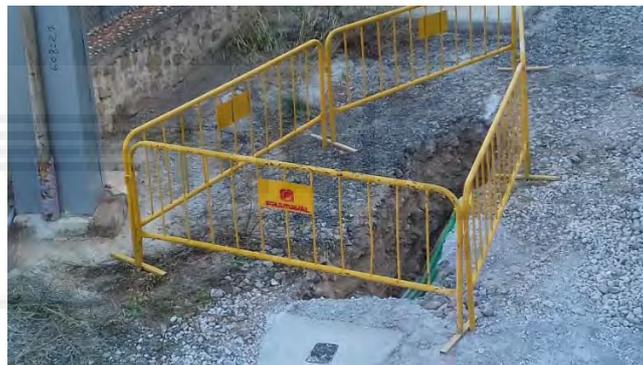
Imagen 17. En esta valla protectora debería dejarse una distancia mayor hasta la zanja
