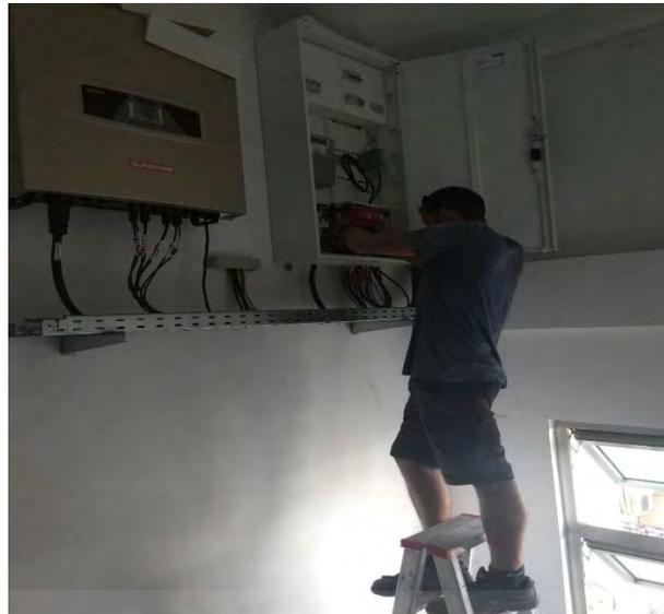
Imagen 39. Ejemplo de operario manipulando un cuadro de baja tensión sin un apoyo sólido y con mala iluminación.
