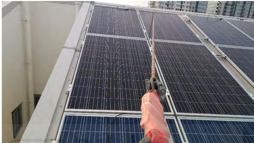
Imagen 26. Sistema anticaída y sistema de absorción de caída.
