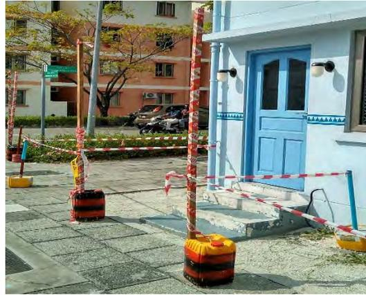
Imagen 5. Se deben colocar barreras materiales para evitar el paso de terceros por zonas en las que pueda haber caída de objetos o herramientas desde las cubiertas
