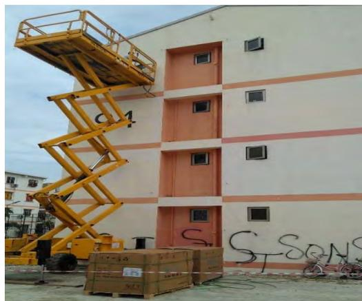
Imagen 32. Elevadora PEMP debidamente anclada, señalizada y con barrera material
