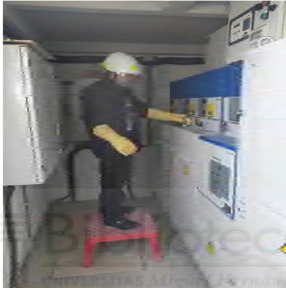
Imagen 40. Ejemplo de operario con todos los elementos de protección, dispuesto a ejecutar la puesta en marcha
