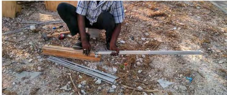
Imagen 37. Ejemplo de operario manipulando perfiles metálicos sin ningún tipo de protección
