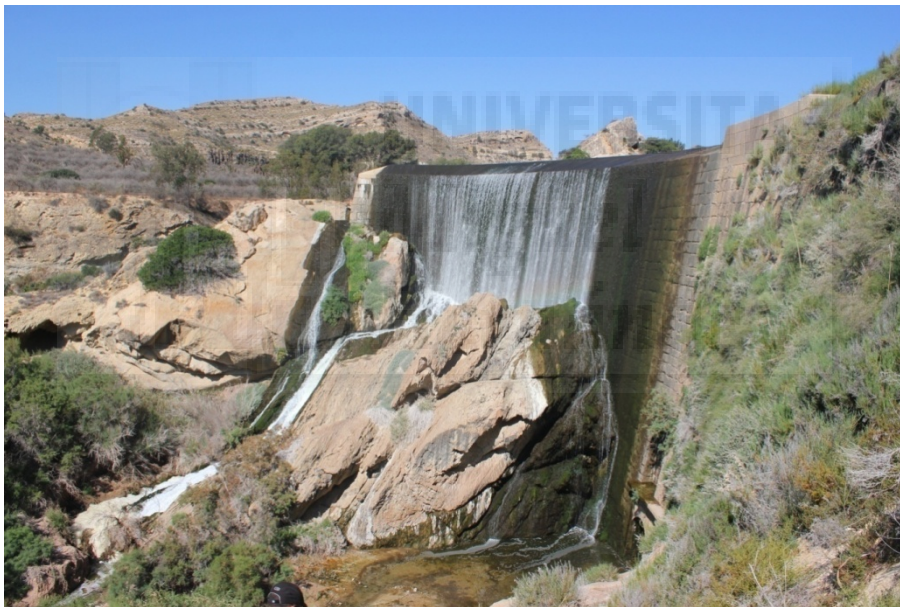
Ilustración 1. Detalle de la presa del embalse de Elche.
