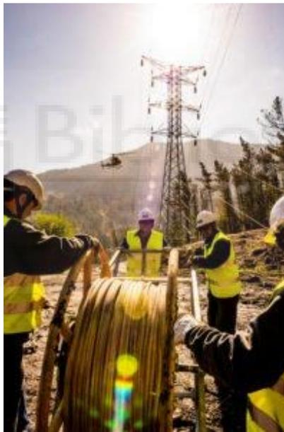
Figura 16. Bobina de cable piloto. Fuente: Google
