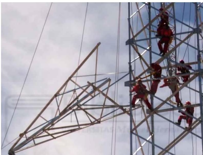
Figura 18. Montaje de estructura metálica en celosía. Fuente: Proalt ingeniería.
