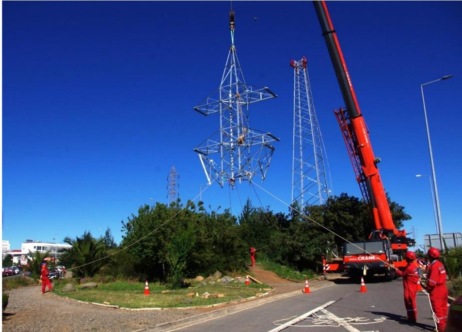
Figura 11. Izado de estructura de torre. Fuente: Google
