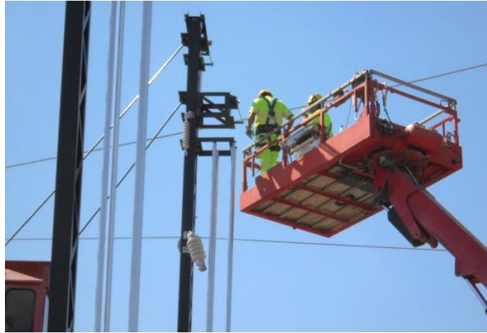
Figura 29. Montaje de tubos guía
