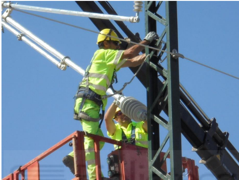
Figura 25. Montaje de ménsulas
