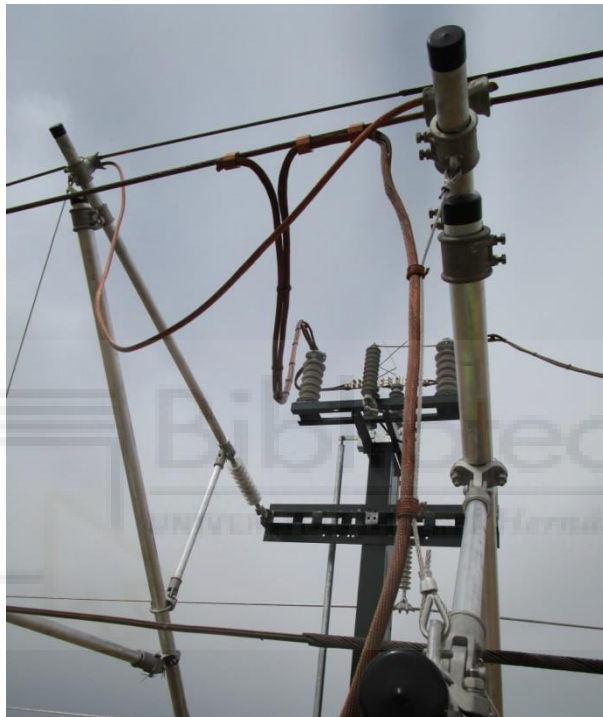
Figura 34. Conexiones de catenaria
