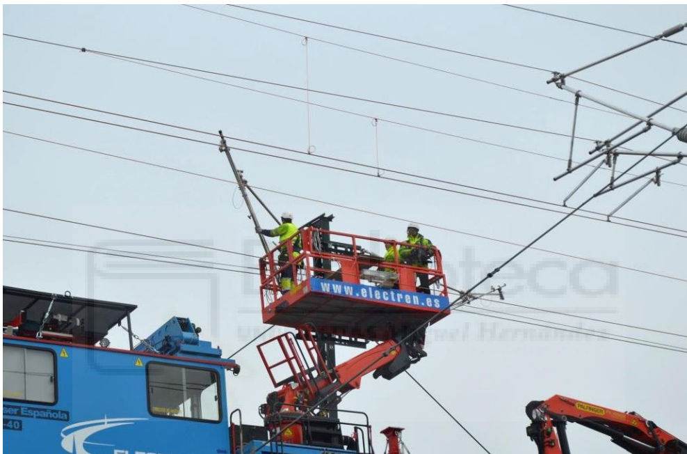
Figura 31. Fijación del sustentador
