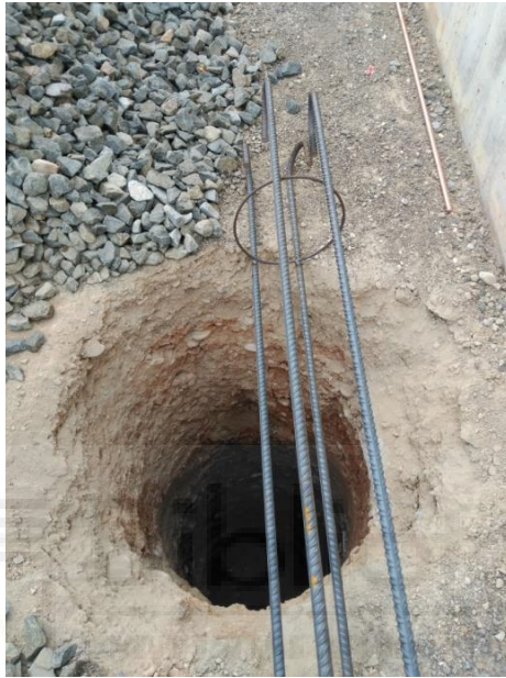
Figura 6. Excavación para cimentación
