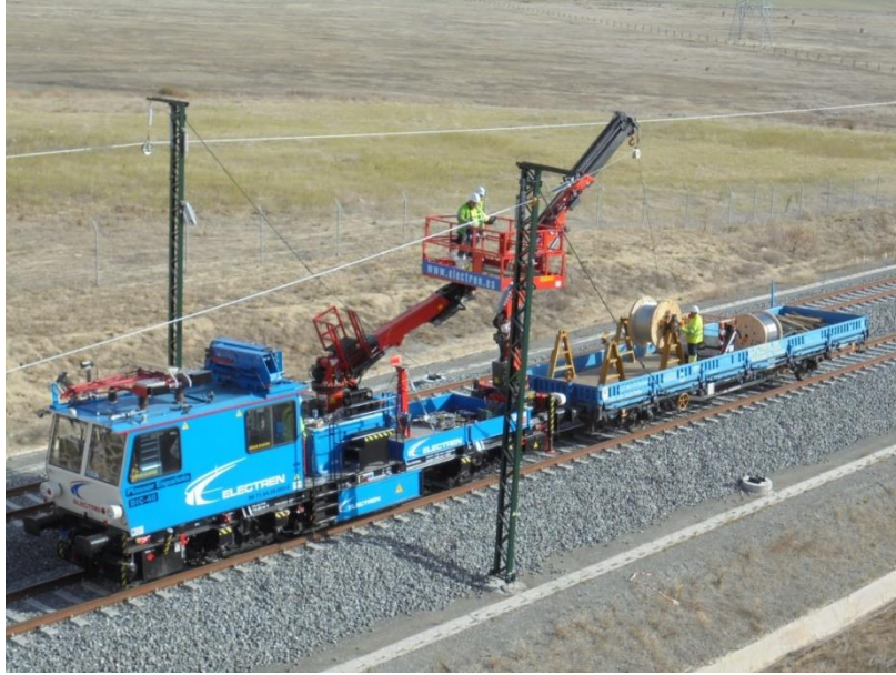
Figura 18. Tendido de feeder
