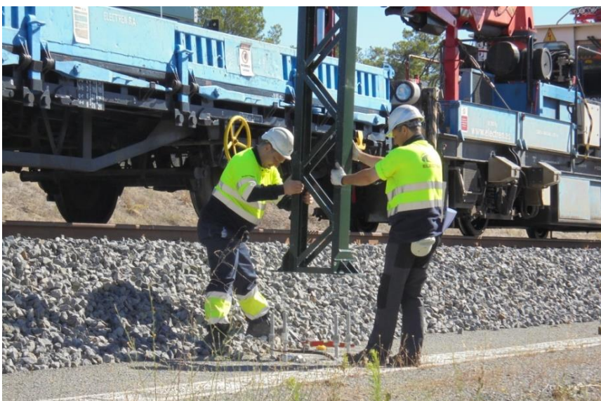
Figura 13. Izado de poste
