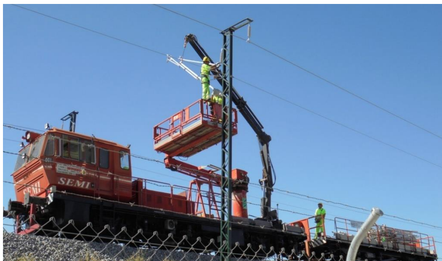
Figura 26. Izado de ménsula
