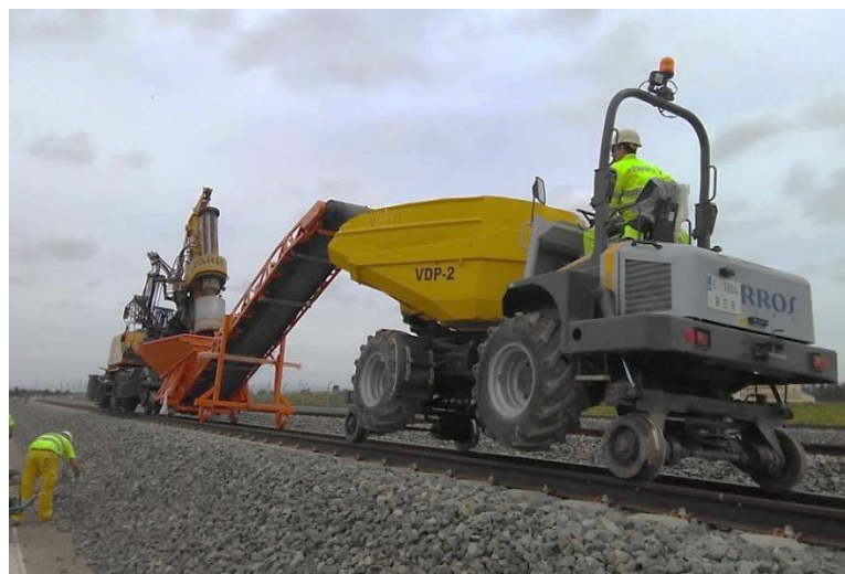
Figura 7. Pilotadora, cinta y dumper
