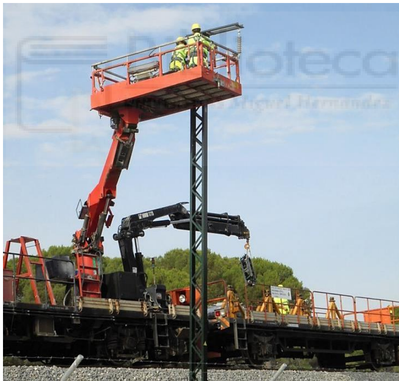
Figura 14. Colocación de silletas
