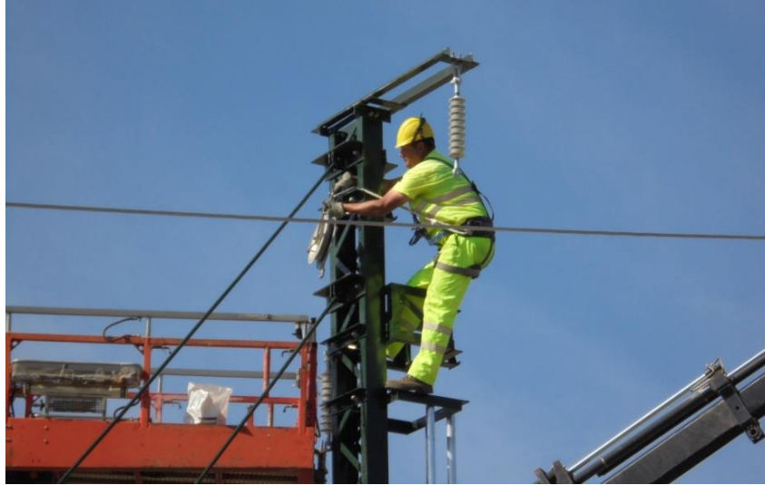
Figura 15. Trabajos desde poste
