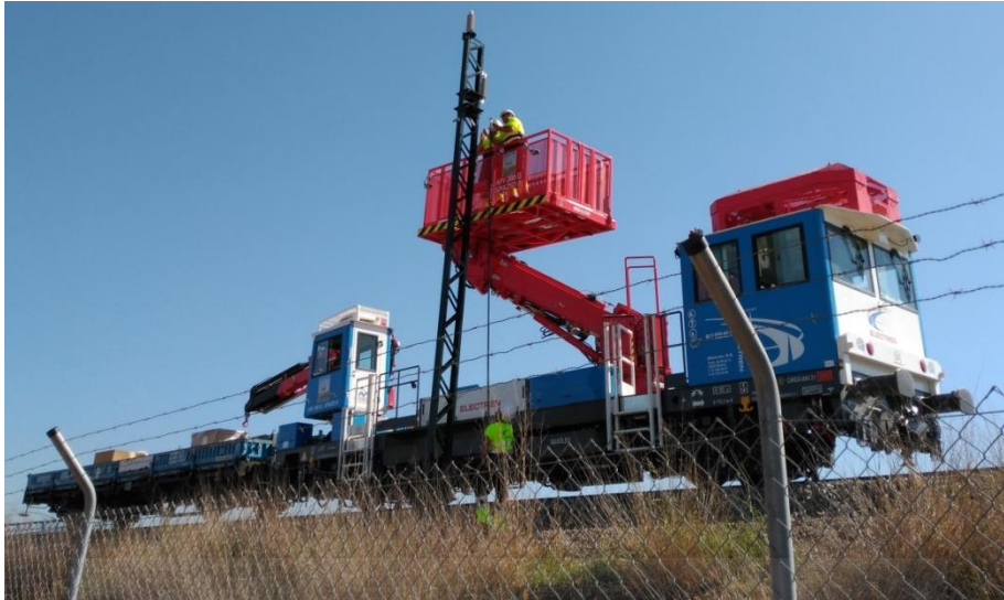
Figura 12. Montaje de tirantes
