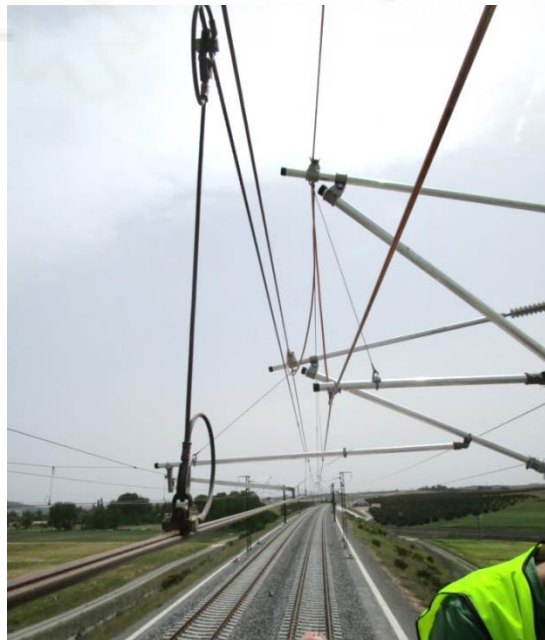
Figura 33. Regulación de catenaria
