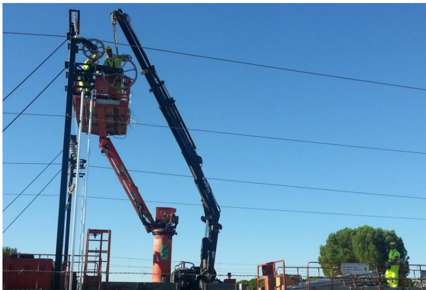
Figura 28. Montaje de poleas
