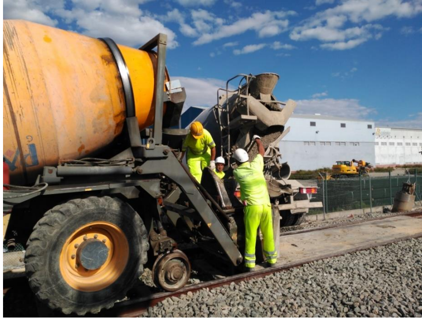
Figura 9. Carga de autohormigonera
