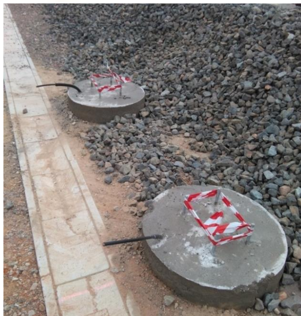
Figura 10. Señalización de cimentaciones
