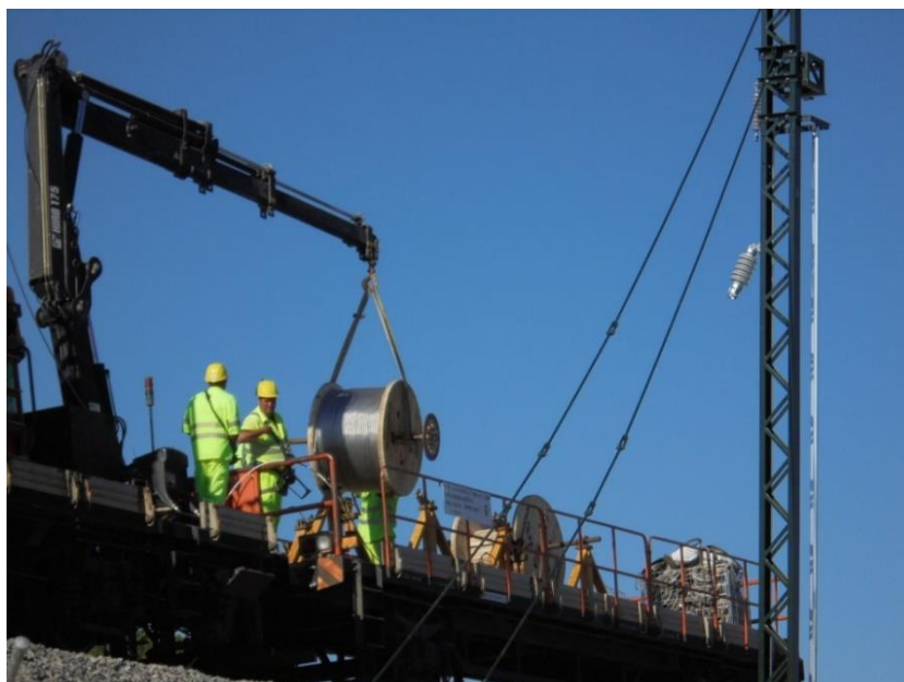
Figura 16. Cargado del portabobinas
