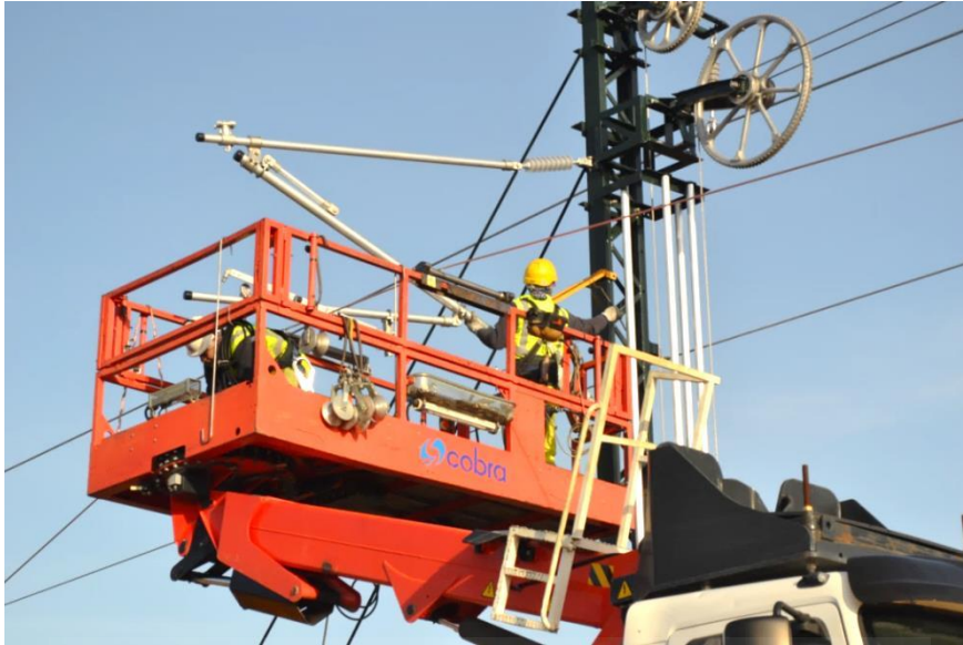
Figura 27. Fijación de ménsula
