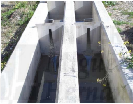
Figura 14: Desarenador estático de flujo constante (García, 2015)
