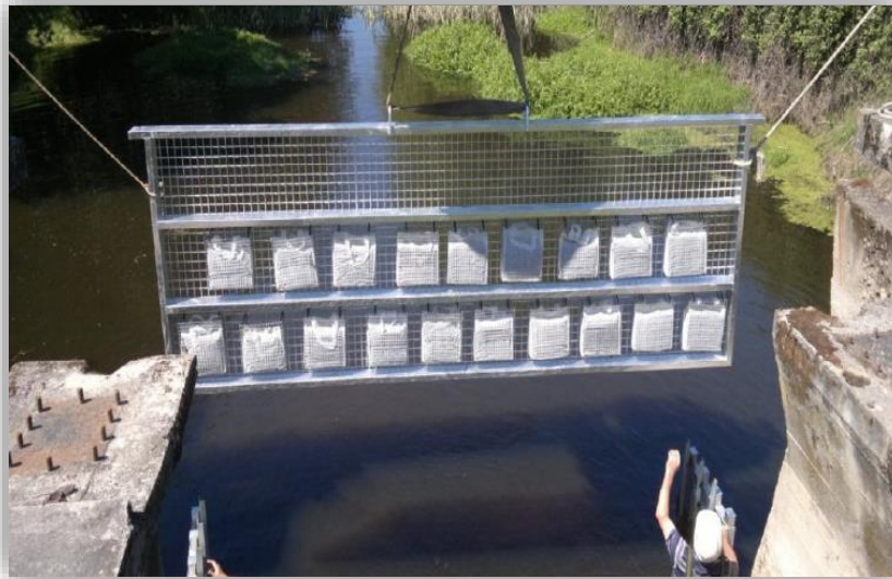
Figura 8. Colocación de bolsas con Technosol en el cauce de un río (Fuente: Bolaños, 2014).
