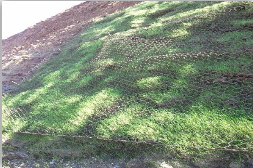
Figura 7. Technosol proyectado en talud (Fuente: Bolaños, 2014).
