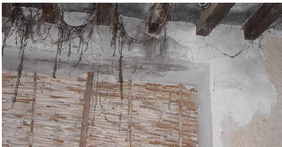
Fig. 4.15. Tabique de separación interior remozado con yeso solo por una cara de la almazara de la finca La Caseta.
