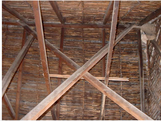
Fig. 1.27. Arriostramiento de la barraca en cruz de San Andrés.
