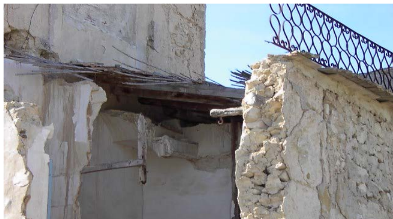
Fig.1.51. Detalle forjado de caña común en la casa de Lo Monte.
