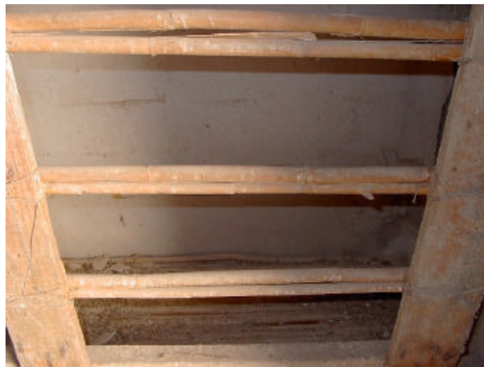
Fig. 4.22. Gallinero. Finca La Caseta.
