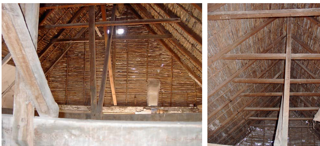
Fig. 1.26. Vigas de forjado de la barraca.
