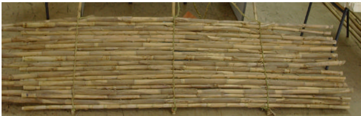
Fig.4.3. Confección del entramado de cañas sobre las cañas guías.
