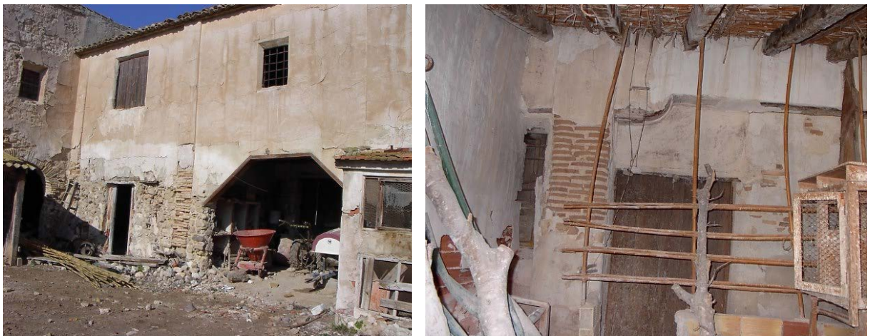
Fig. 1.44. Estructura de edificación con pilares de ladrillo y vigas de madera. Alquería de la finca La Caseta.
