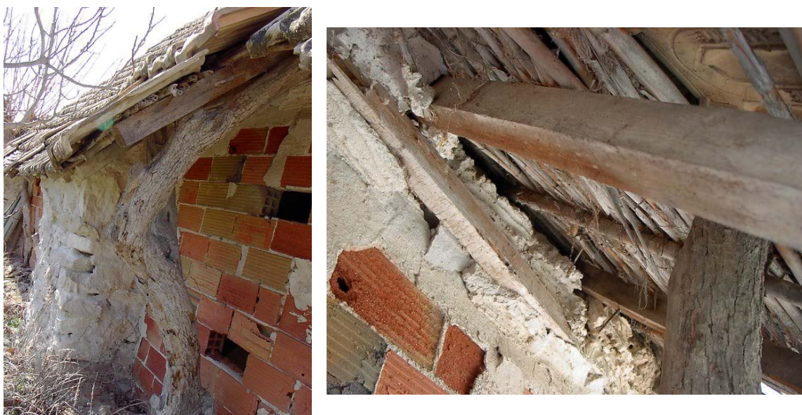
Fig. 1.25. Detalles de sujeción de la viga de atado a los pilares en la barraca.
