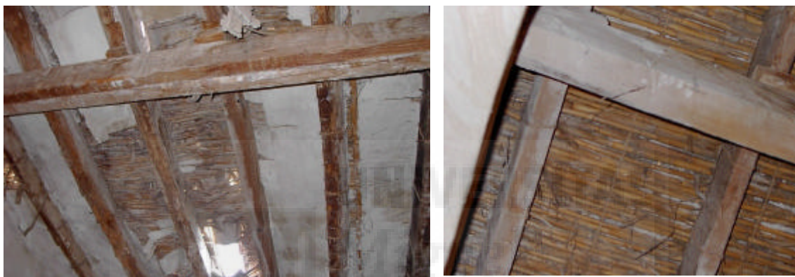
Fig. 4.6. Forjado de cubierta tipo A.
