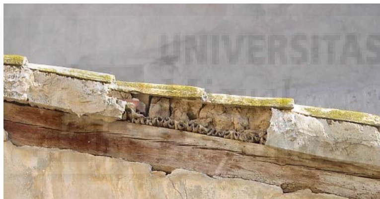
Fig. 1.54. Detalle de cañas en forjado de cubierta y teja árabe.
