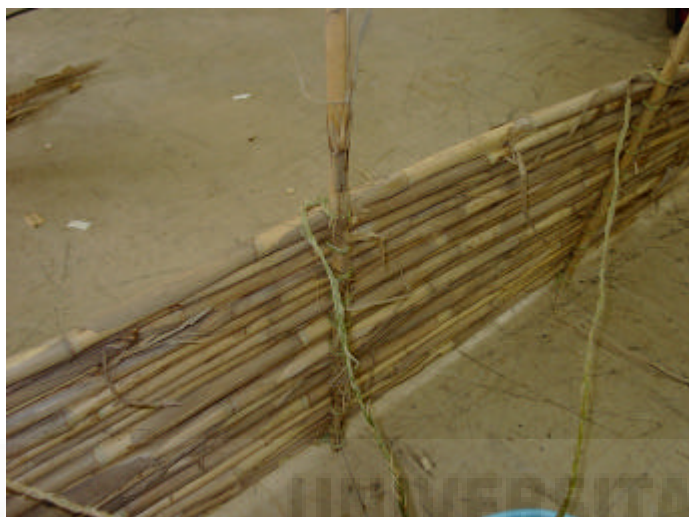
Fig. 4.14. Construcción del tabique con cañas (testero).
