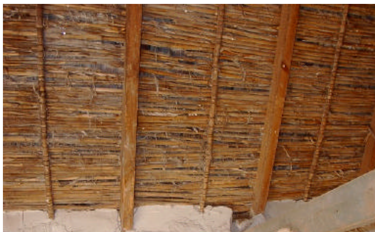
Fig. 4.9. Forjado de cubierta tipo D. (Barraca)
