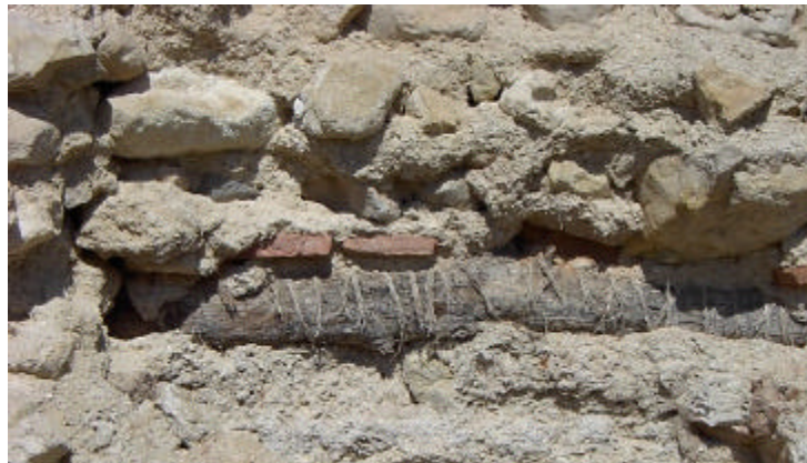
Fig. 4.4. Detalle de atado con cuerda de esparto del extremo del entramado de cañas a una viga en el muro de carga.
