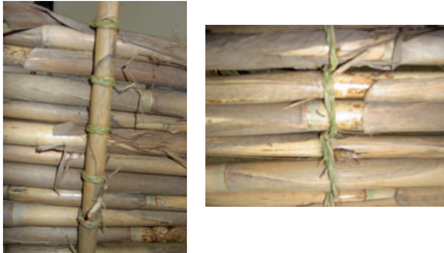
Fig. 4.2. Tejido de cañas para forjado (mollije).
