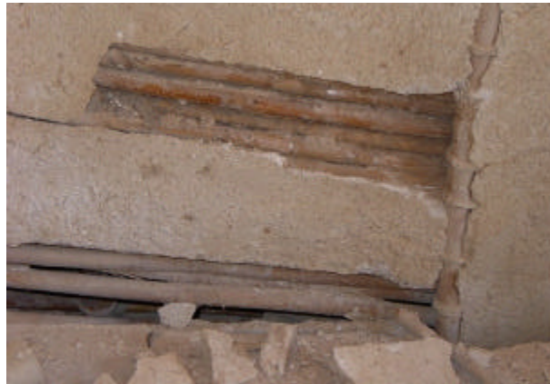
Fig. 4.18. Tabique remozado con yeso por los dos lados de gran espesor.
