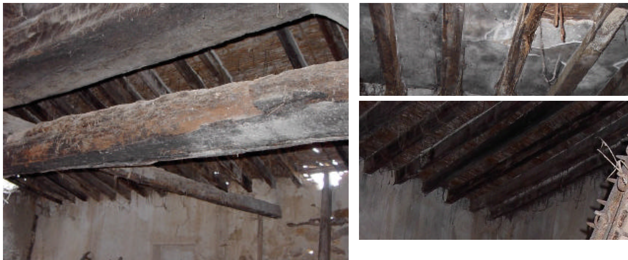
Fig. 4.39. Estructuras de madera y cañas sometidas a fuego.
