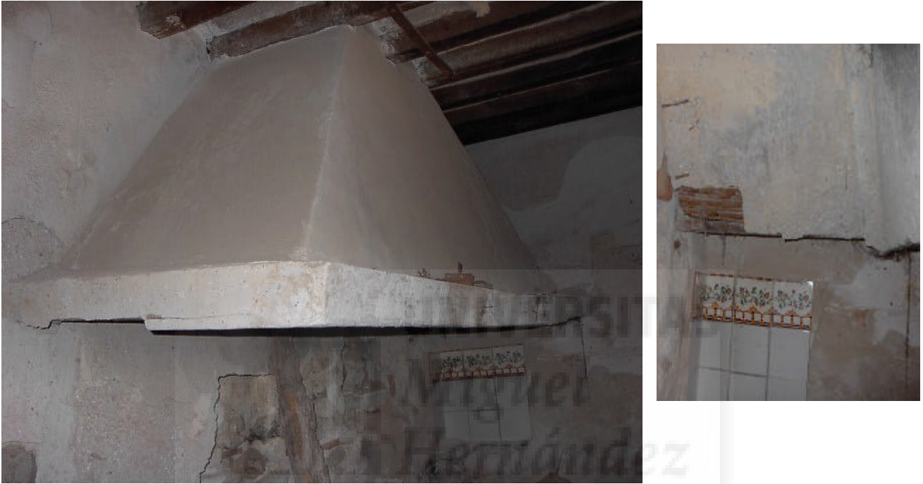
Fig. 4.21. Chimenea de la alquería finca La Caseta y detalle del interior de caña.
