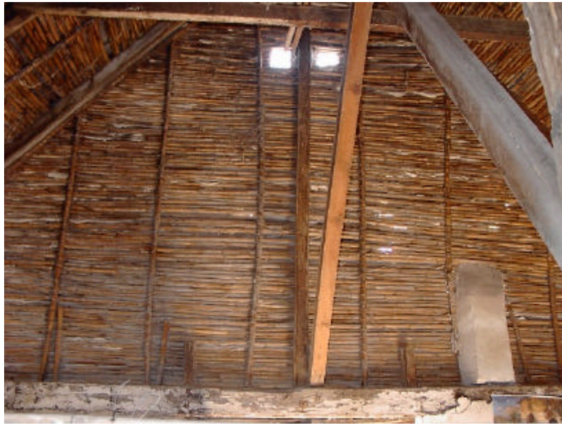
Fig. 4.16. Cerramiento de la barraca de la finca La Caseta.
