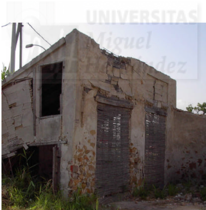
Fig. 4.17. Edificación (alojamiento ganadero) de pilares de mampostería y cerramientos de caña unos paramentos remozados y otros no, para ventilación.
