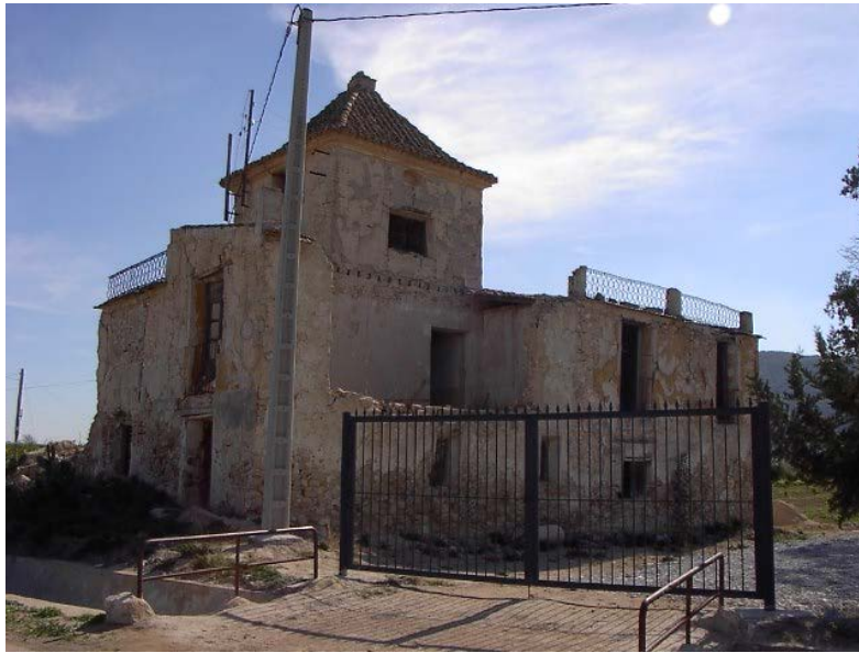
Fig. 1.50. Vista posterior. Casa de la finca de Lo Monte. Siglo XVIII..(Orihuela).
