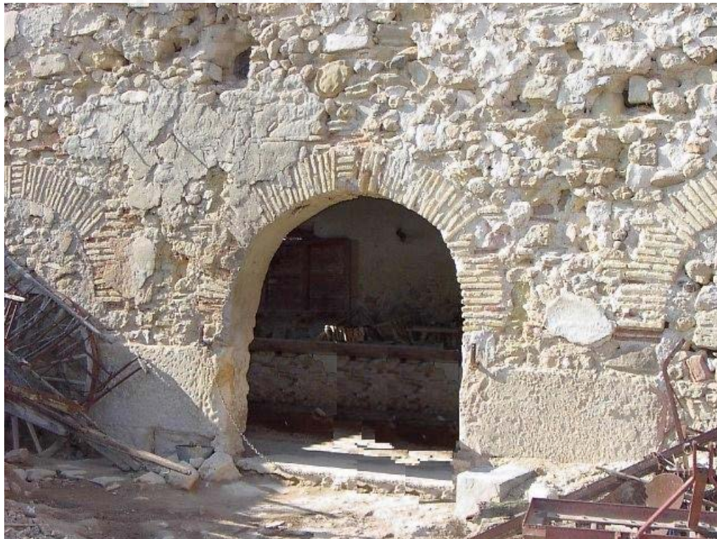
Fig. 1.42. Arco de medio punto exterior. Alquería de la finca La Caseta.(Orihuela).
