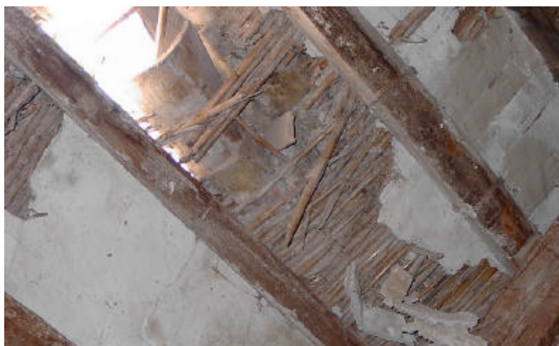
Fig. 4.42. Forjado de cubierta de cañas de una edificación del siglo XVIII, descompuestas por hongos y carcoma por exceso de humedad.
