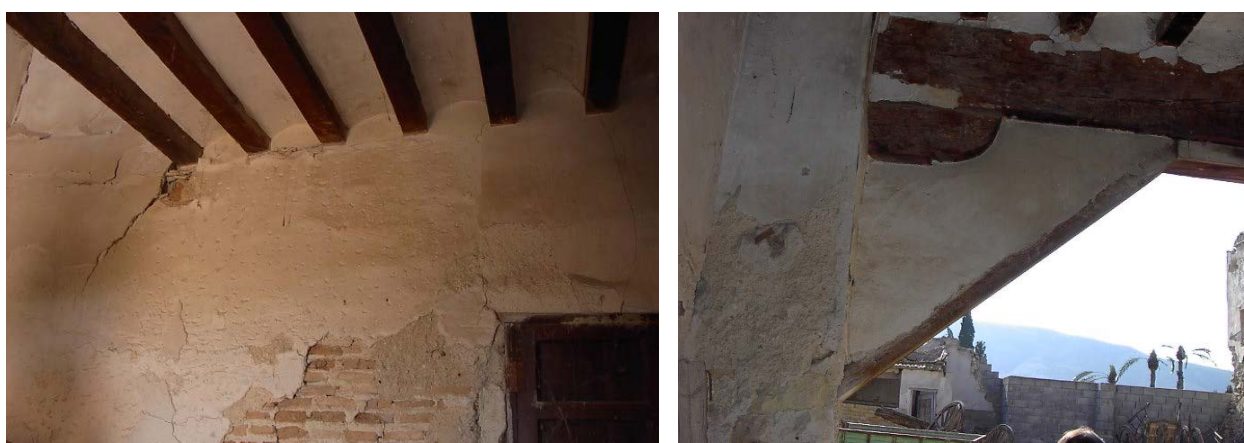
Fig. 1.38. Otras disposiciones de vigas de forjado de piso de la alquería de la finca La Caseta.
