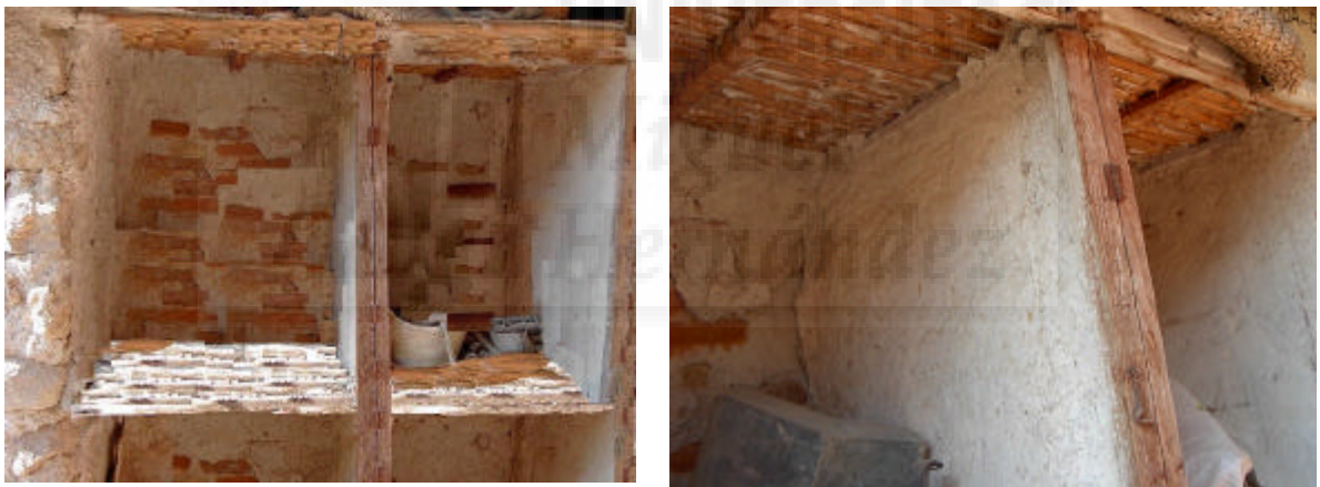
Fig. 4.24. Estantes y armarios de la alquería finca La Caseta.
