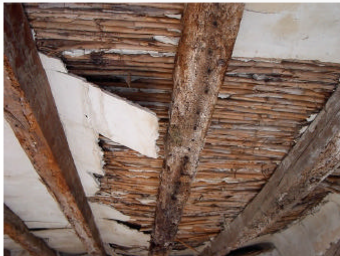
Fig. 4.12. Forjado de piso tipo C.
