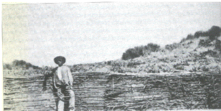
Fig. 1.16. Cañizo para contención de dunas. Ingeniero Larramendi.
