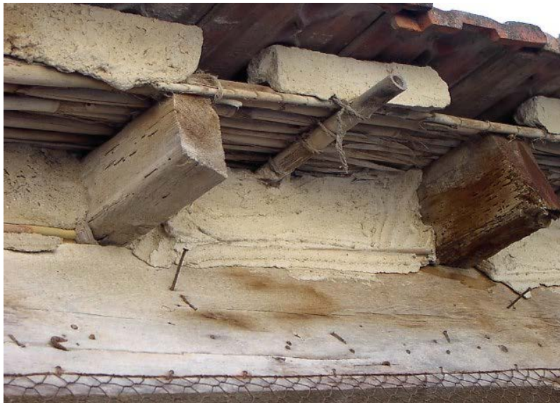
Fig. 1.53. Detalle de caña común en forjados (mollijes) y teja alicantina.
