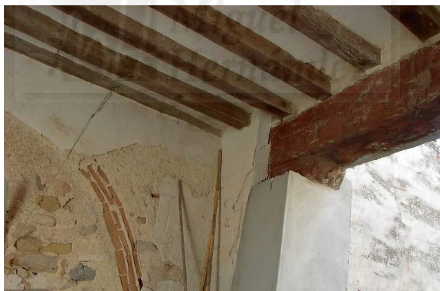
Fig. 1.36. Arcos de ladrillos macizos en muros. Alquería finca La Caseta (Orihuela)
