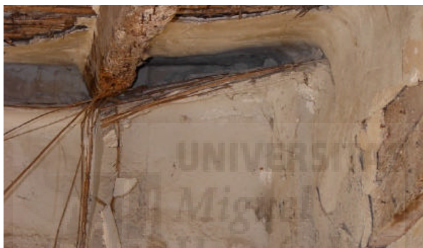
Fig. 4.19. Detalle de púas para unir el falso techo de cañizo.
