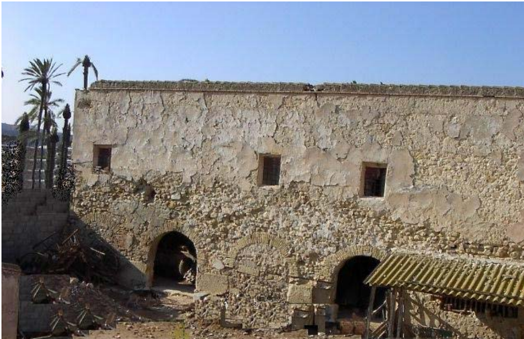
Fig. 1.39. Patio interior de arcos de la alquería de la finca La Caseta.
