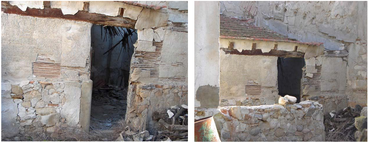
Fig. 1.45. Detalle de cerramientos con caña. Alquería de la finca La Caseta.
