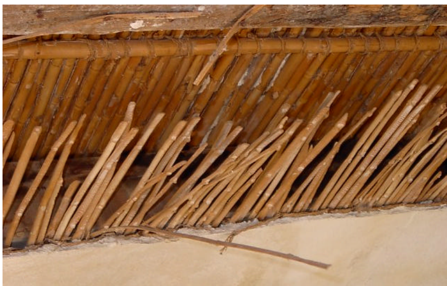
Fig. 4.20. Forjado de caña y falso techo de cañizo, alquería finca La Caseta.
