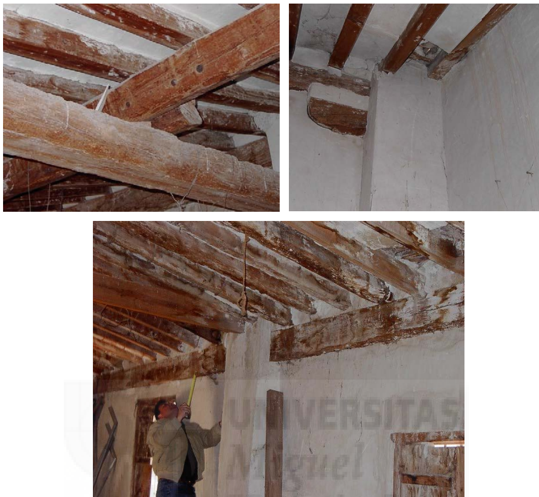
Fig. 1.37. Vigas de forjado de cubierta y detalles de la alquería de la finca La Caseta.(Orihuela).
