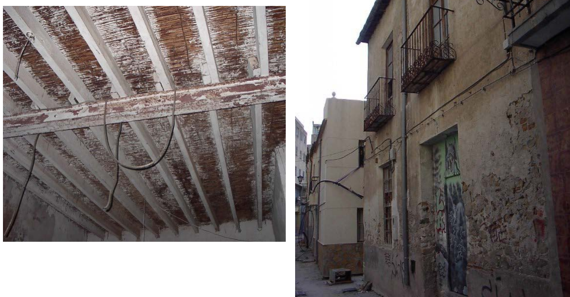
Fig. 1.48 .Casa urbana del siglo XVIII. Orihuela (Alicante). Detalle de forjados.
