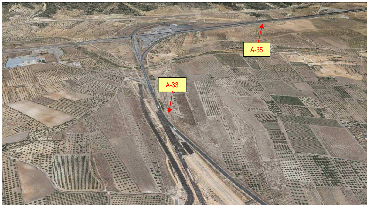
Situación actual vista desde el sur. (Fuente: Google. Elaboración: propia).
