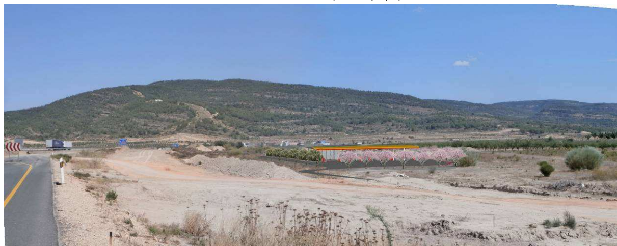
Foto nº 7.- Esta panorámica es la misma que la reflejada en la fotografía nº 9, pero con las medidas de integración paisajística propuestas, plantaciones de prunus dulcis y olea europea alrededor de la estación de servicio. (Fuente: propia).
