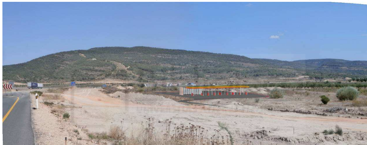
Foto nº 6.- Esta panorámica es la misma que la reflejada en la nº8, pero se ha incluido la nueva Estación de Servicio, vista desde la isleta de acceso. Se puede observar la marquesina actual, que quedaría para suministro a los camiones, la marquesina que se pretende construir, para suministro a los coches, y en medio el edificio. Como la ampliación de 40 m 2 se realizaría por la parte posterior, en esta panorámica no se notaría. A la derecha, entre el monolito de publicidad y la marquesina de coches se crearía el aparcamiento de coches, y a la izquierda de la marquesina de camiones estaría el acceso al aparcamiento de camiones, situado detrás de edificio, por lo que no se vería, ya que además estará a una cota inferior. (Fuente: propia).
