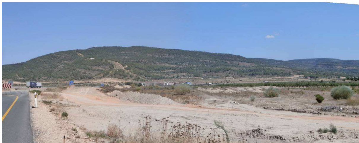
Foto nº 5.- Panorámica efectuada en las inmediaciones de la A-33, a la altura de las parcelas donde se ubicará la Estación de Servicio. En el lado izquierdo de la imagen aparecen plantaciones agrícolas, y en el fondo escénico está la Sierra de Enguera. (Fuente: propia).
