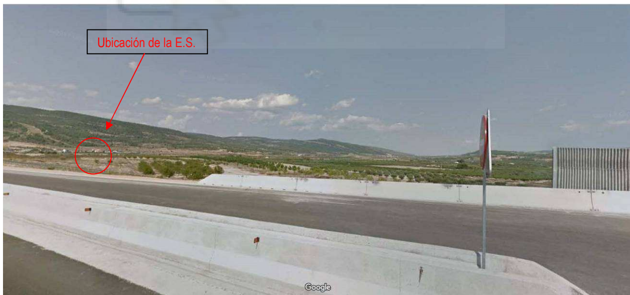
Foto nº 2.- Panorámica hacia la Estación de Servicio, vista desde la calzada derecha de la A-33, sentido A.35. Se visualizan parcelas destinadas al cultivo y, en el fondo, la Sierra de Enguera (Fuente: Google. Elaboración: propia).
