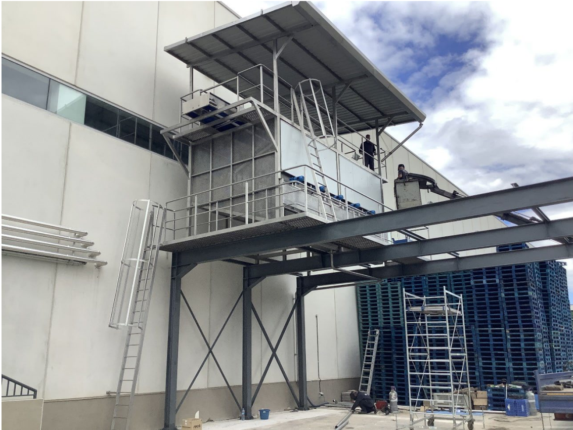
Figura 54. Silo durante el montaje
