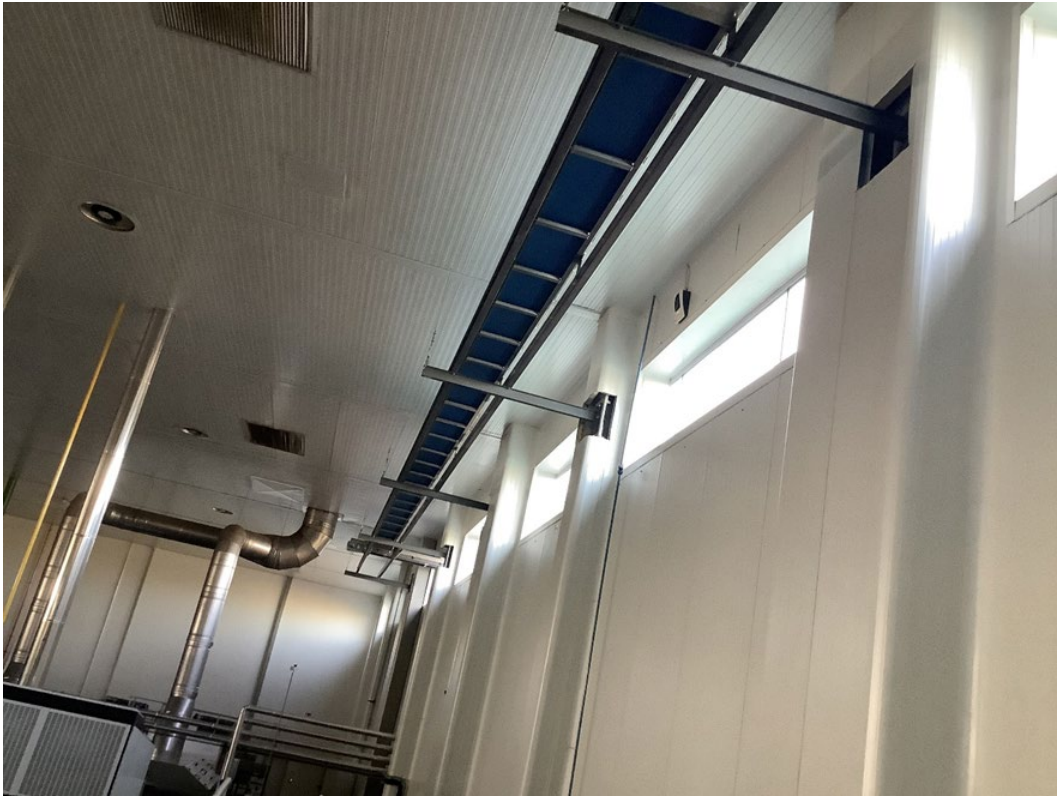
Figura 51. Transportador de correa elevado
