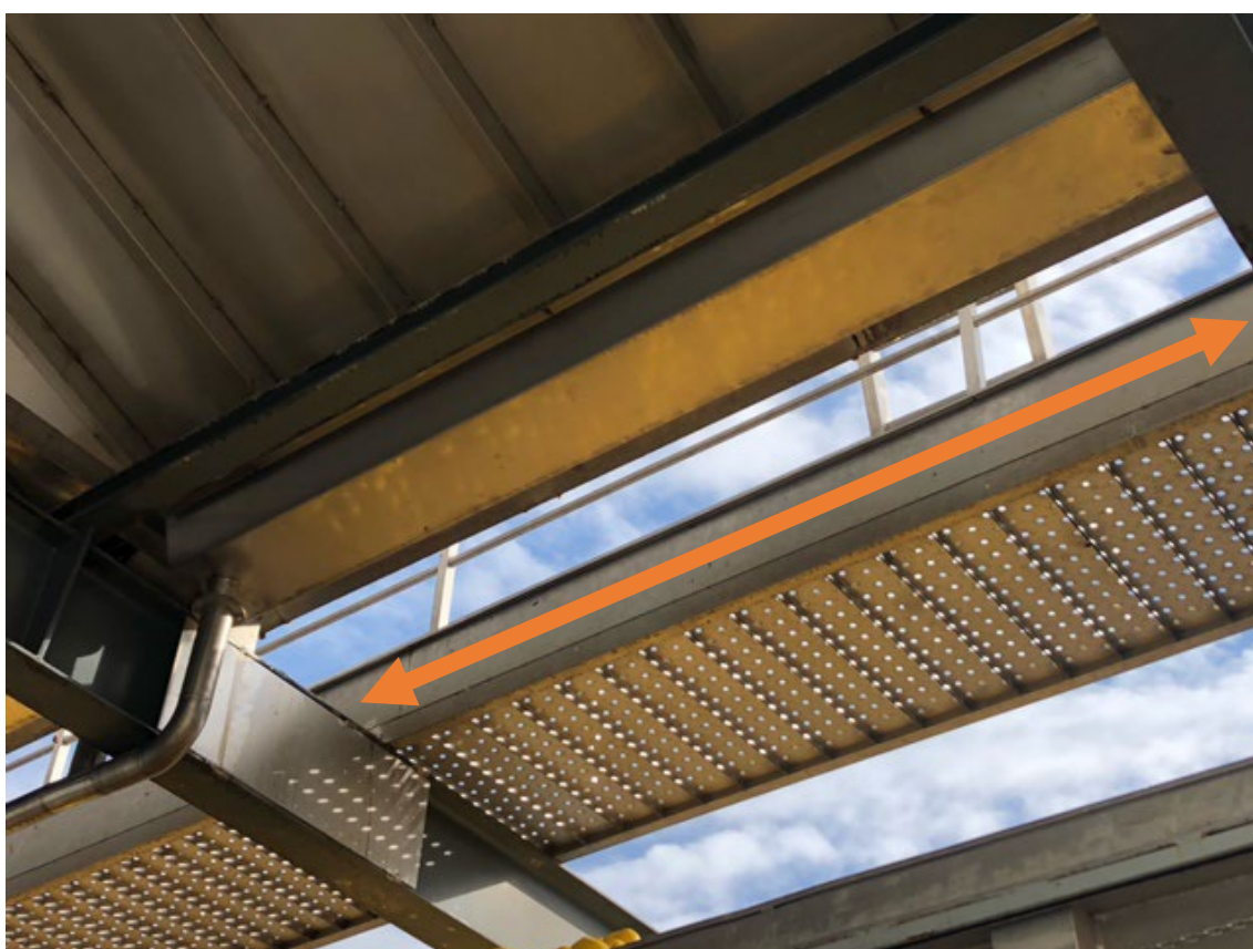
Figura 106. Zona prevista para mejora
