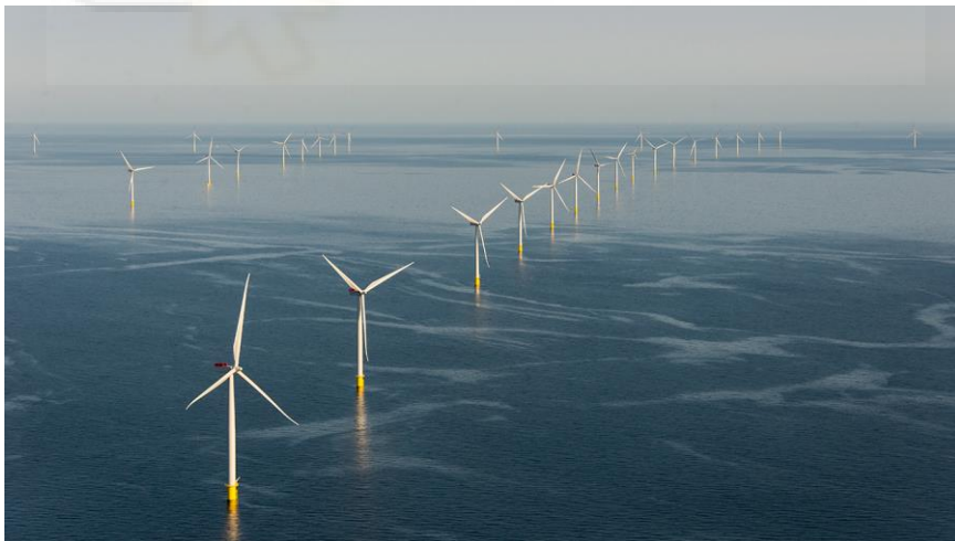
Figura 9: Parque eólico offshore Anholt
