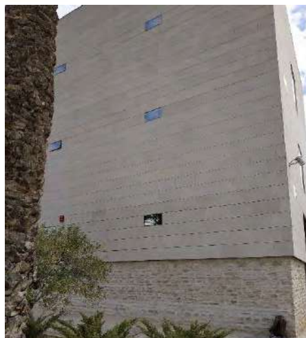
Ilustración 4-2. Situación del acceso pasarela (Fachada)
