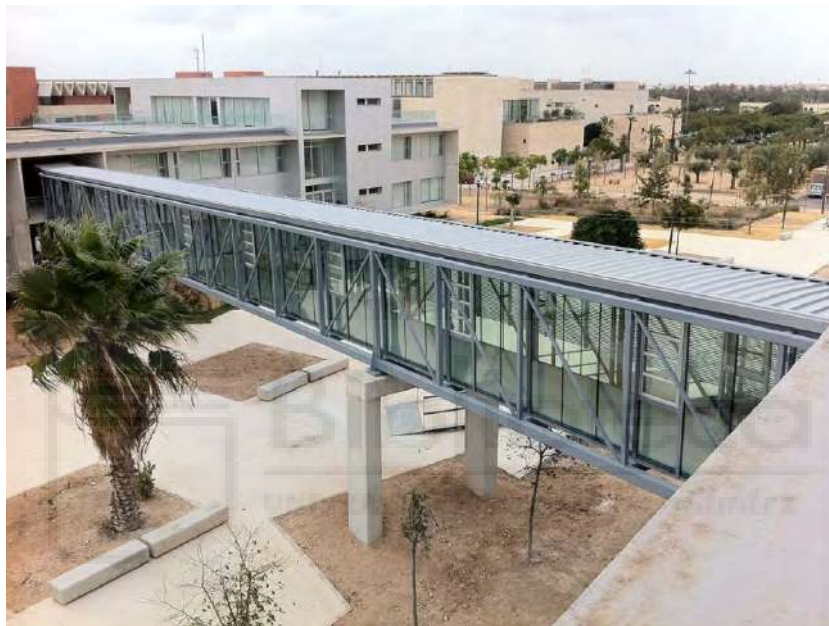
Ilustración 2-3. Pasarela I+D+i (UMH)
