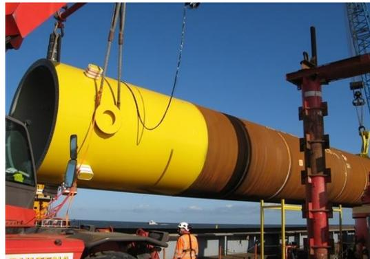
*Figura 16 Transporte de monopilote [17]*
