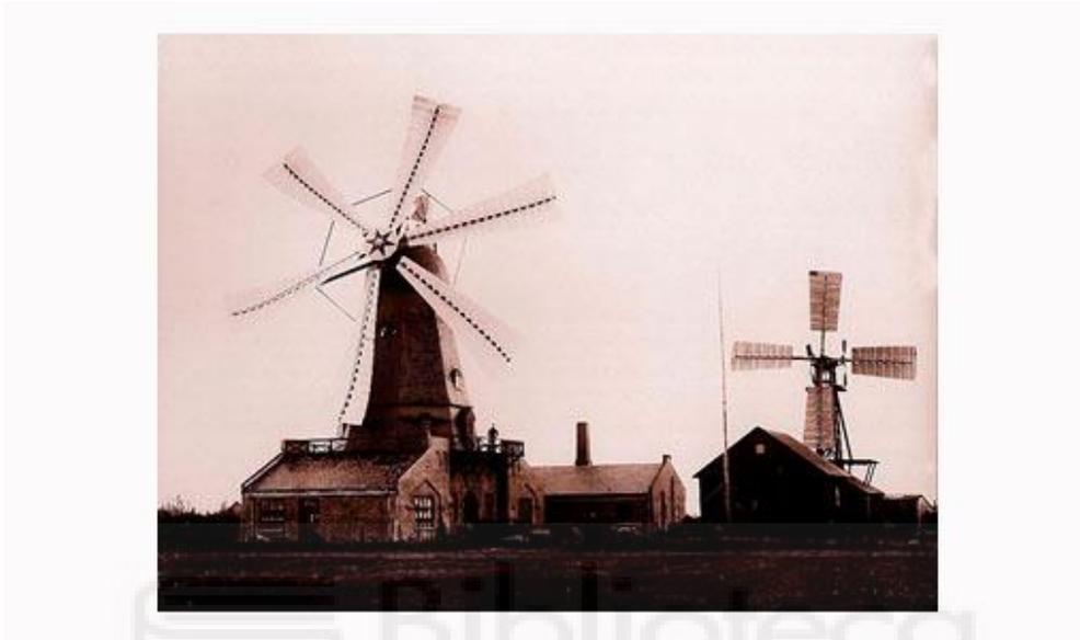
Figura 4 Aerogenerador de prueba de la Cour [4]
