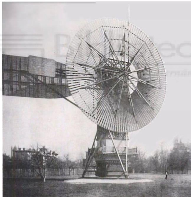
*Figura 3 Primer aerogenerador eléctrico [4]*
