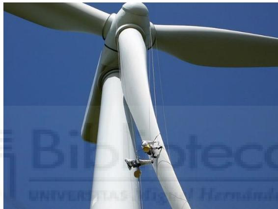
*Figura 83 Operarios realizando mantenimiento predictivo de las palas de un aerogenerador [50]*
