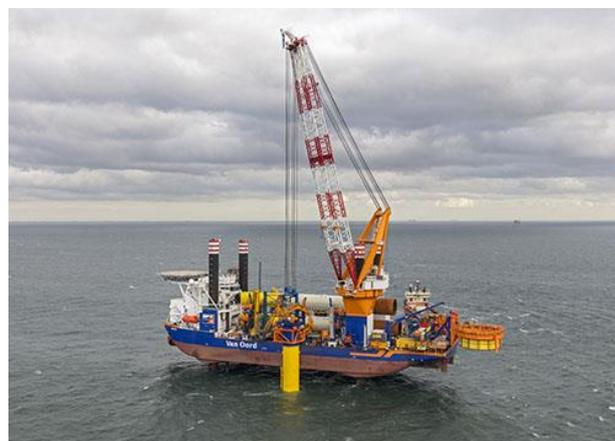
*Figura 17 Instalación de monopilote [18]*
