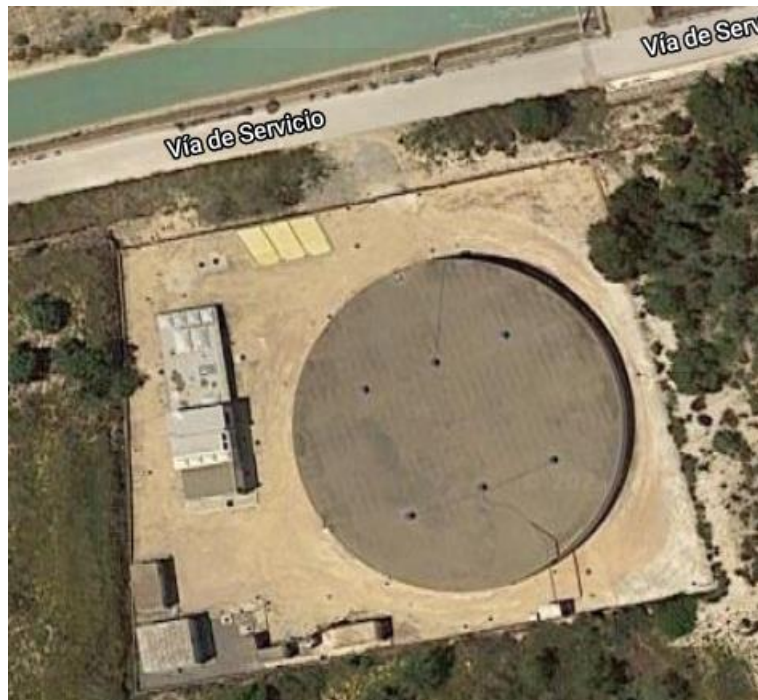
Figura 1.2. Vista satélite Estación El Canal
