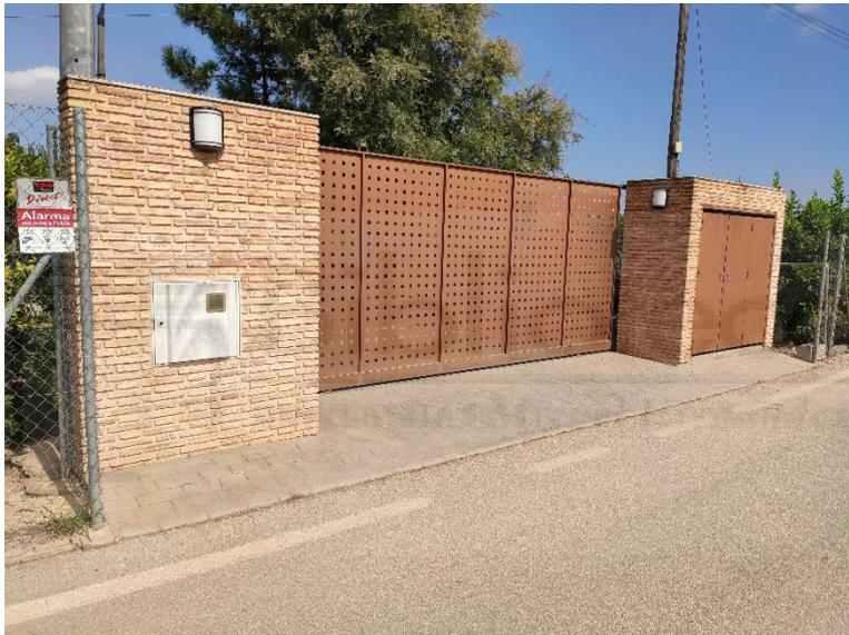
*Ilustración 45 CGPM en el límite exterior de la propiedad.*
