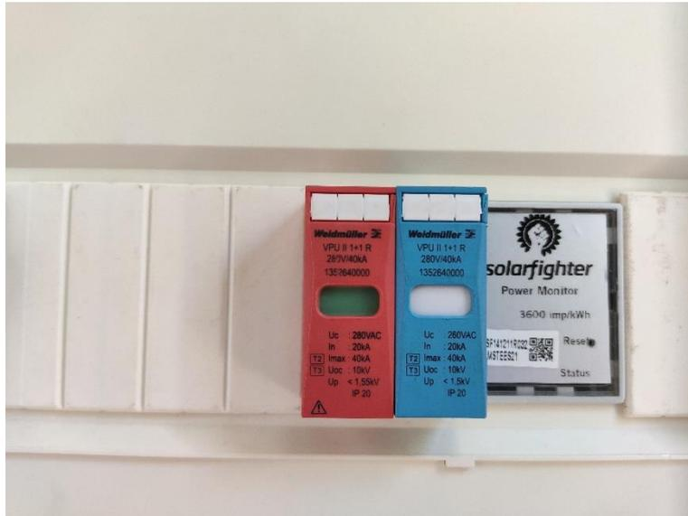
*Ilustración 43 Protecciones de sobretensiones AC existentes*
