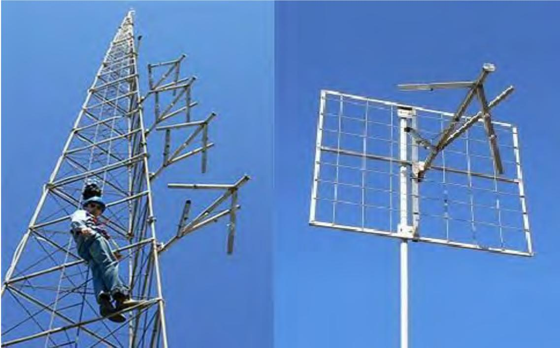
**Figura 3.10** – Array antenas dipolo en V, a la izquierda y antena dipolo en V con reflector, a la derecha. (Fuente: [Radioenlaces.com](http://Radioenlaces.com))
