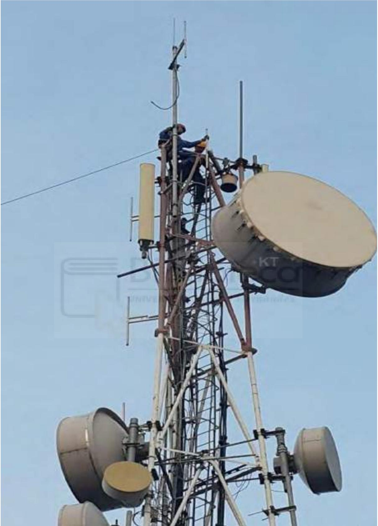
**Figura 3.124** - Operario instalando los dipolos de alta potencia en la torre del centro emisor de KT Radio en Nyarupfubire, 28 de febrero de 2016. (Fuente: [Kigalitoday.com](http://Kigalitoday.com))
