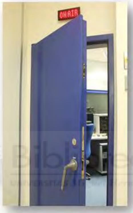
**Figura 3.88** - Puerta acústica Acústica Integral RS3 51 dB. (Fuente: Radio UMH)
