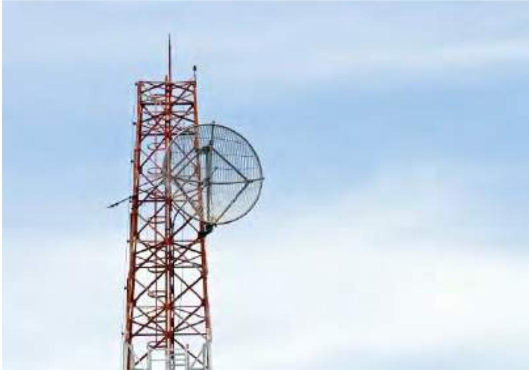
**Figura 3.13** – Antena parabólica tipo rejilla. (Fuente: [Freepik.es](https://www.freepik.es))
