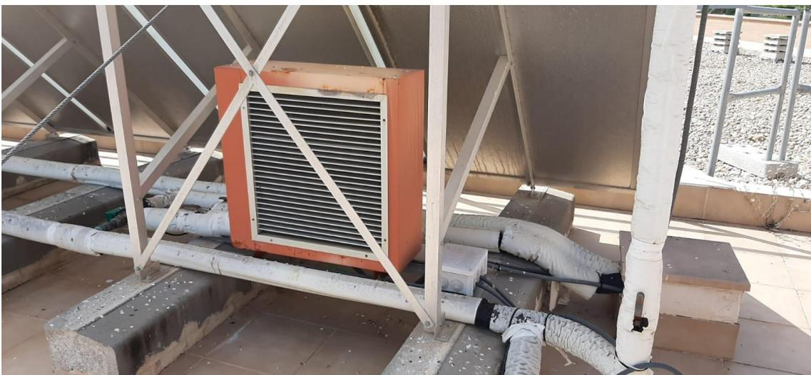
Figura 5. 5: Disipador de calor.
