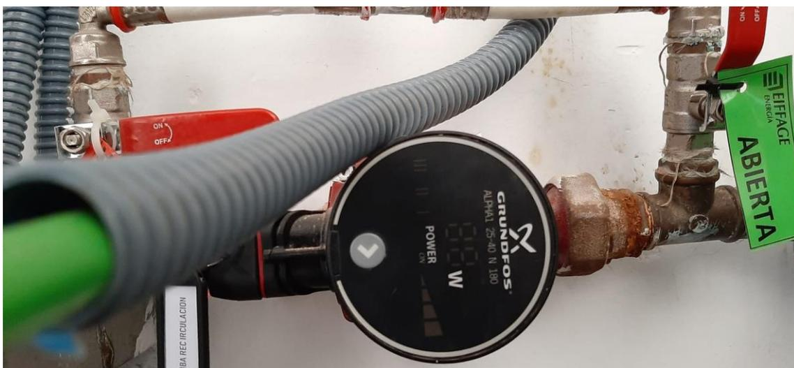
Figura 5. 28: Bomba encargada de la recirculación.
