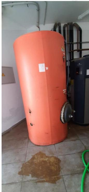
Figura 5. 7: Depósito solar.
