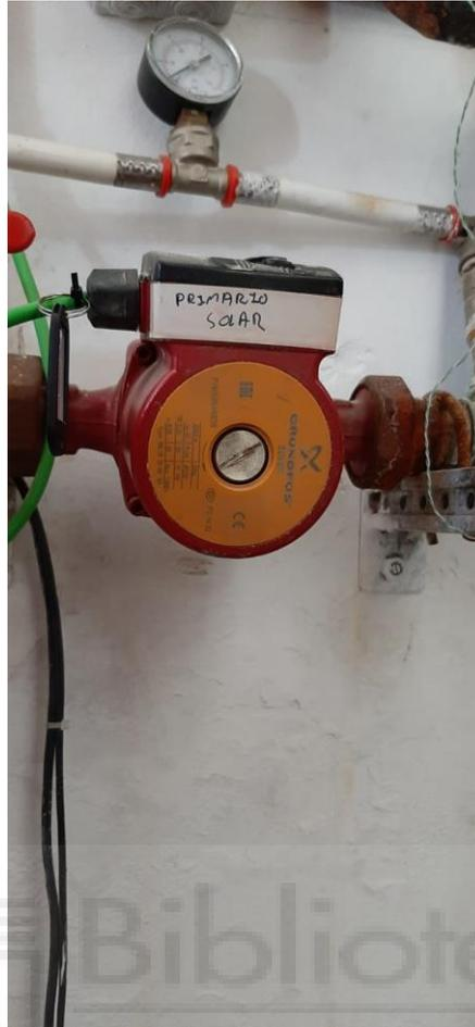
*Figura 5. 8: Bomba circulación circuito primario.*
