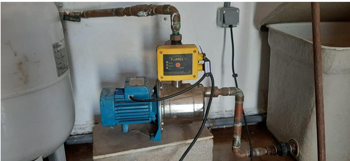
Figura 5. 10: Bomba llenado del circuito primario.
