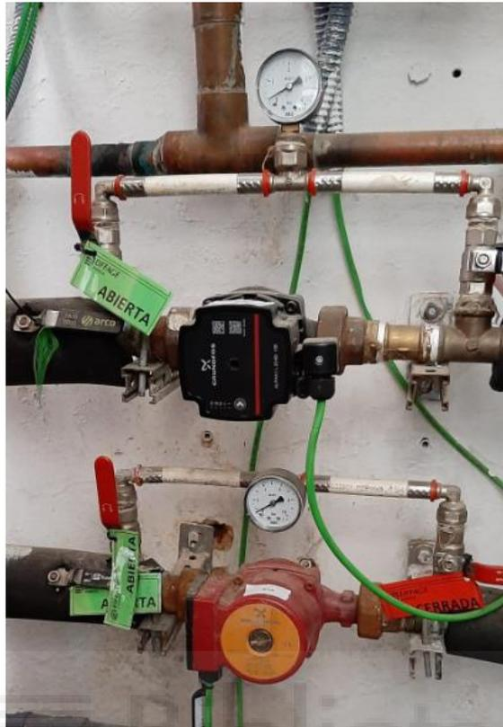
Figura 5. 27: Disposición de las bombas número 3 (arriba) y 4 (abajo).
