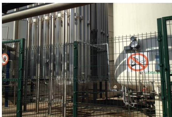
Figura 3.6. Sistema de enriquecimiento de oxígeno.
