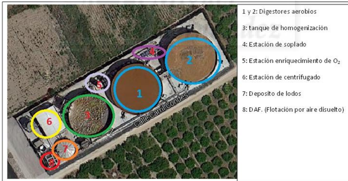
Figura 3.2. Estación depuradora de aguas residuales agroindustriales, Raal, Murcia.
