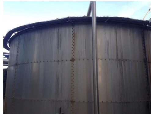
Figura 3.7. Depósito de lodos.
