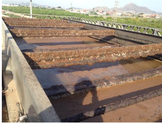
Figura 3.3. Unidad de tratamiento físico-químico de flotación por aire disuelto (DAF).
