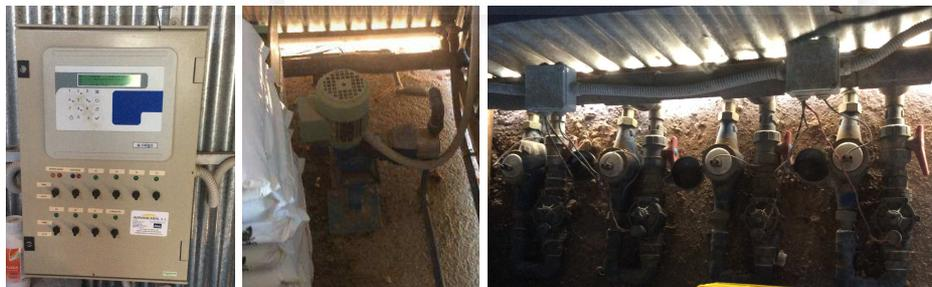
**Figura 19.** Equipo de bombeo, abonado y programador empleados en la finca.
