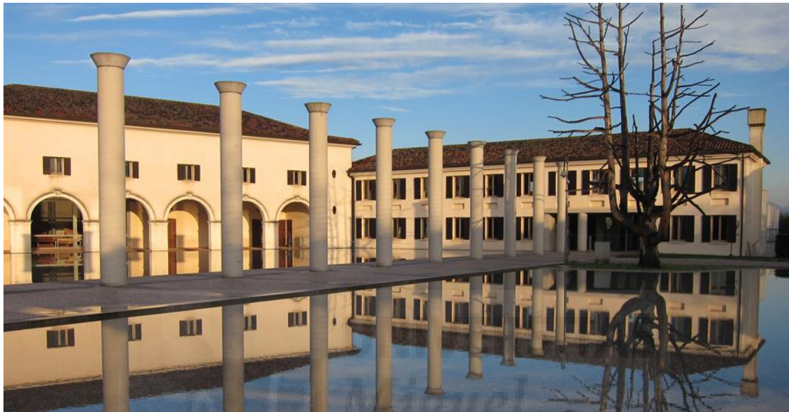
Instalaciones de Fabbrica en Treviso, Italia
