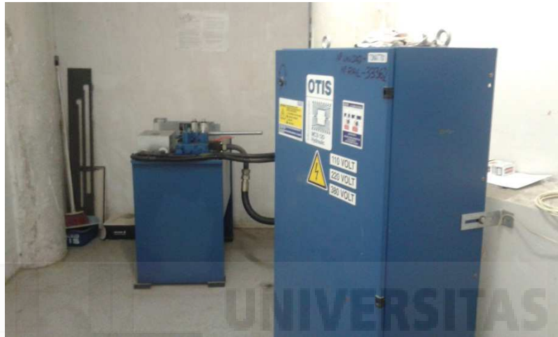
Cuarto de maquinaria ascensor
