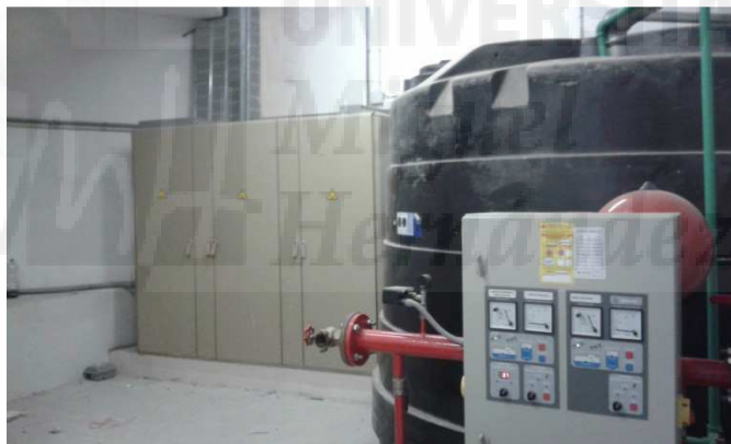
Cuadro Principal y equipo de bombeo
