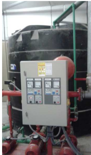
Foto del equipo de bombeo y su depósito
