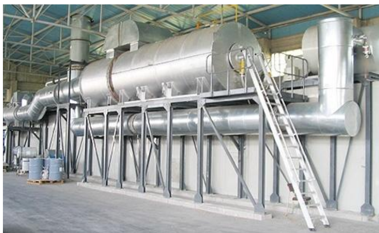
Imagen 18. Incinerador térmico recuperativo. Porcentaje muy elevado de destrucción de COV's (99 %)
