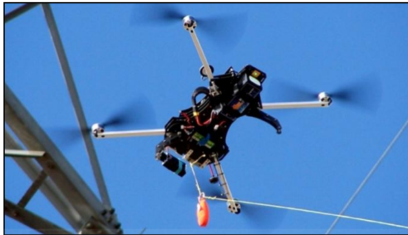
Dron utilizado para la instalación de línea de ascensor en torre eléctrica.
