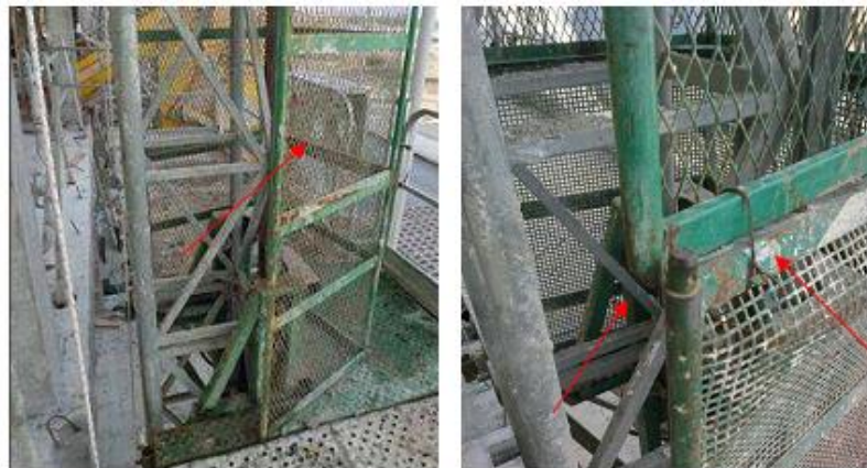
Camisas protectoras del mástil sin sujetar. Deberá garantizarse su estabilidad mediante los tornillos de fijación que se indican en el Manual de Instrucciones del andamio para evitar el riesgo de atrapamiento o su vuelco accidental.
