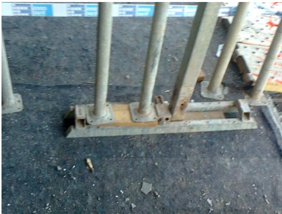
Regleta en forjado inferior
