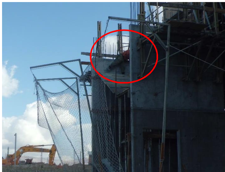
Trabajador encofrando en 2ª planta de escalera sin protecciones
