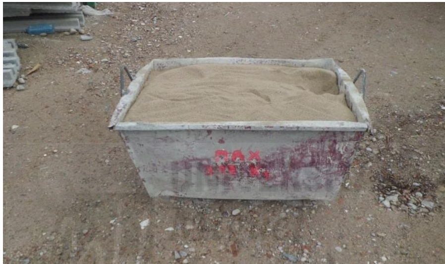
Cuba de mortero llena de mortero previamente a su izado
