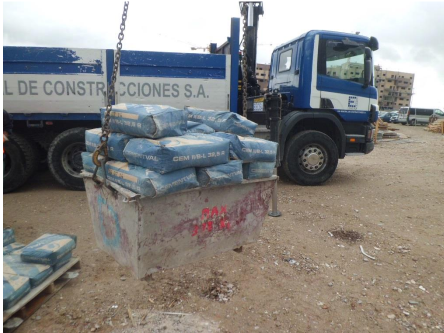
Izado de la cuba de mortero con 900 Kg. de carga.
