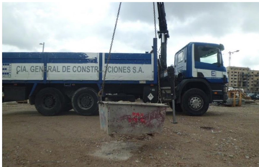
Izado de la cuba de mortero con 600 Kg. de carga.
