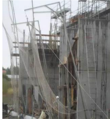
Redes de seguridad sujetas con clavos de acero o sueltas
