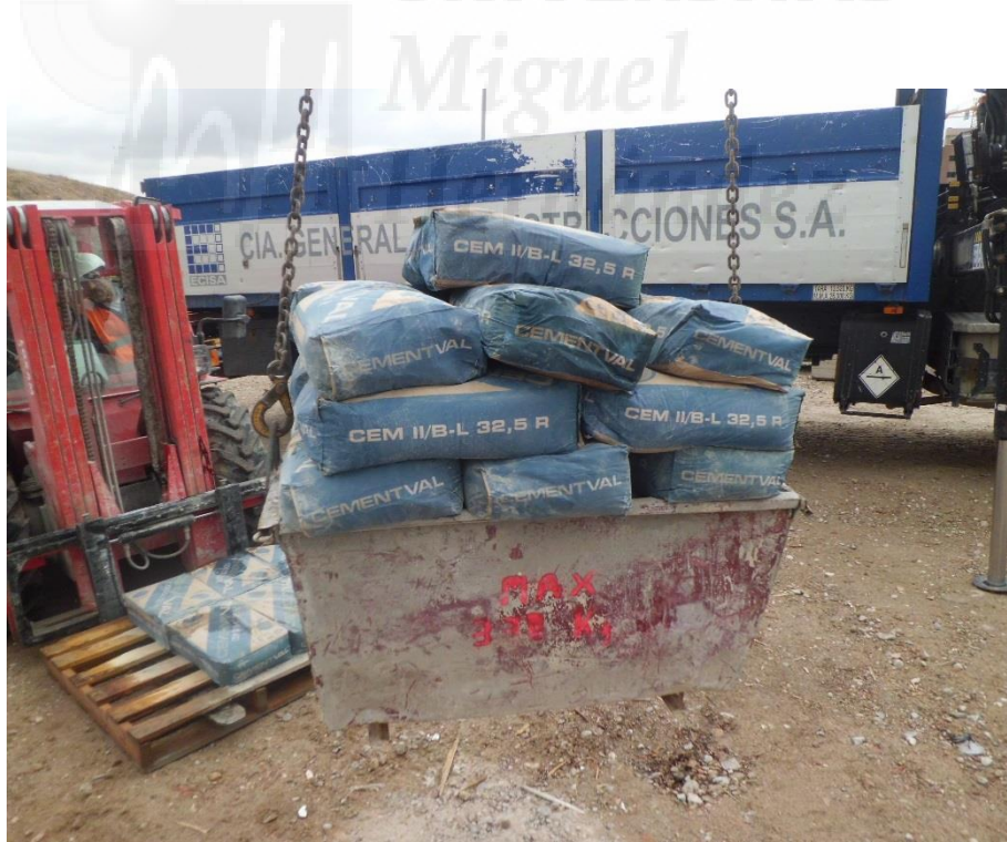
Izado de la cuba de mortero con 1.000 Kg. de carga.
