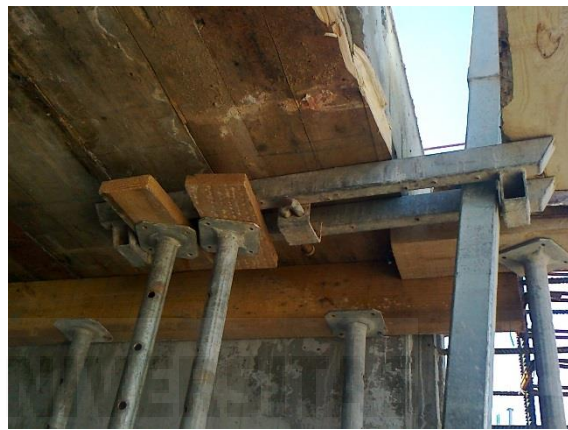
Regleta en forjado superior
