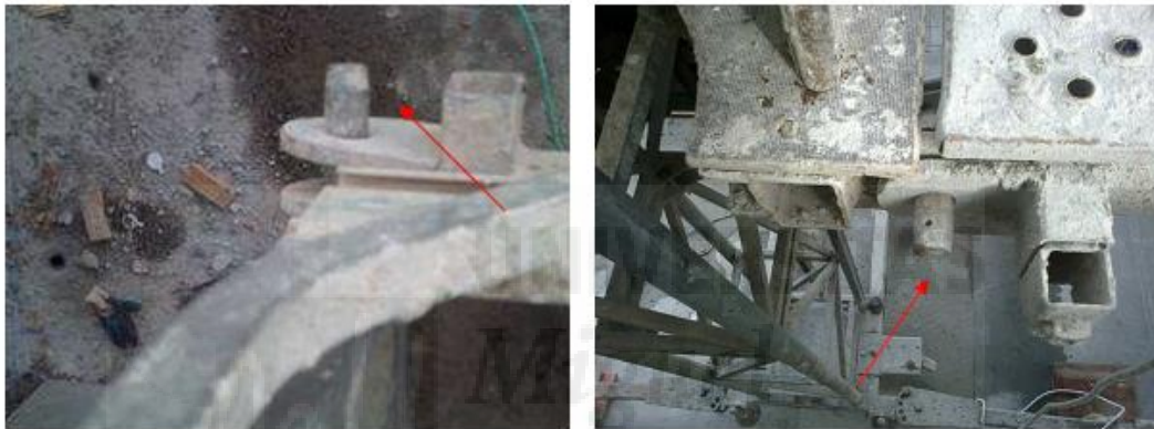
Bulones de unión entre piezas sin el pasador de seguridad.
