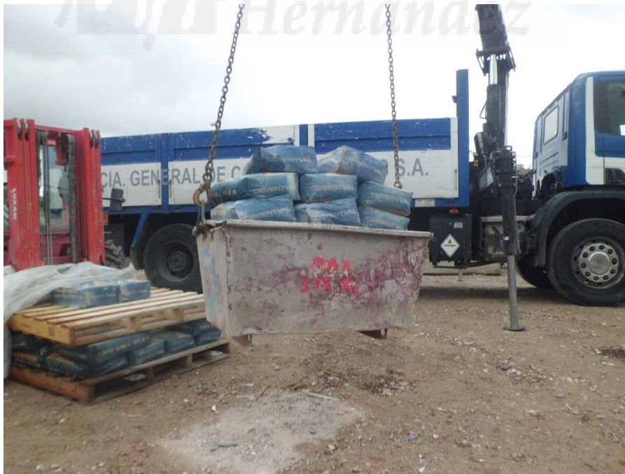
Izado de la cuba de mortero con 800 Kg. de carga.
