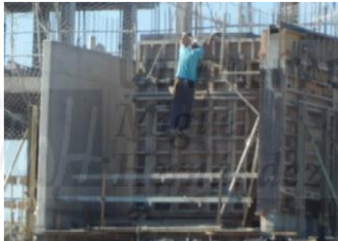
Trabajador trepando por moldes de encofrado sin procciones colectivas y/o individuales
