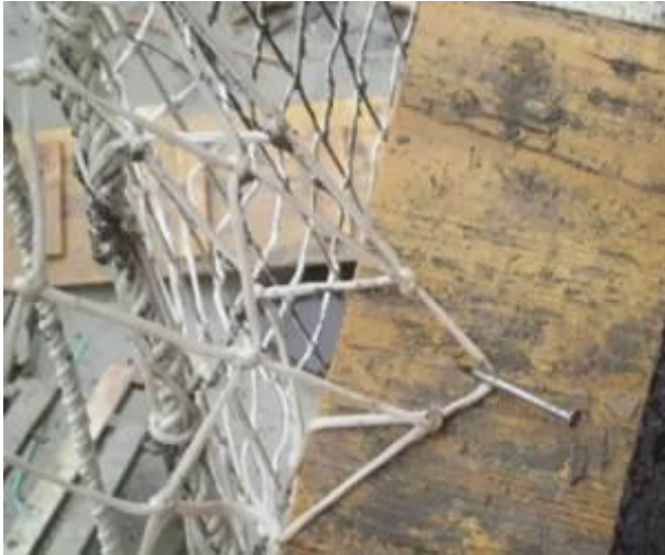
Redes de seguridad sujetas con clavos de acero o sueltas
