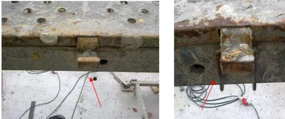
Enganches para la fijación de las planchas metálicas que conforman la plataforma de trabajo sin la pinza/grapa de amarre.
