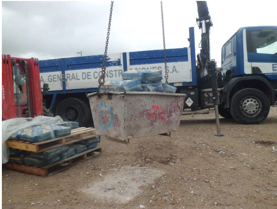
Izado de la cuba de mortero con 700 Kg. de carga.
