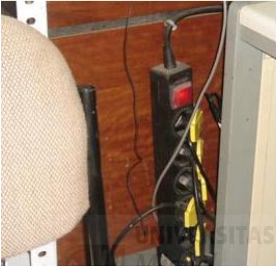
Figura 4. Sobrecarga de tomas de corriente detectada.
