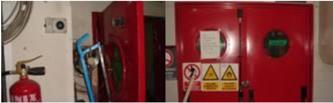
Figura 7. Objetos en puertas RF que obstaculizan su apertura.
