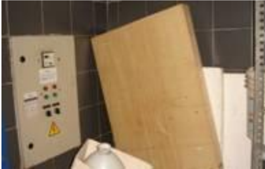
Figura 6. Material combustible junto a cuadro eléctrico.
