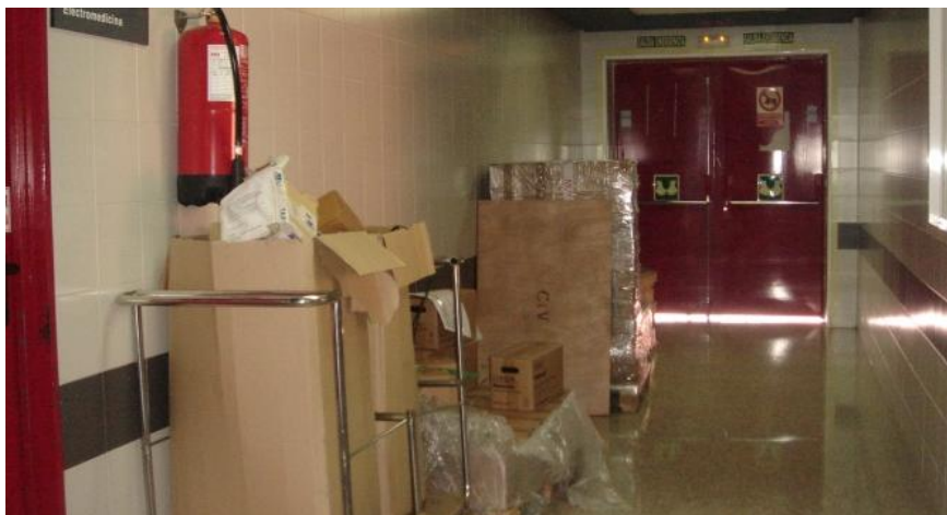
Figura 8. Obstáculos en vías y salidas de evacuación.
