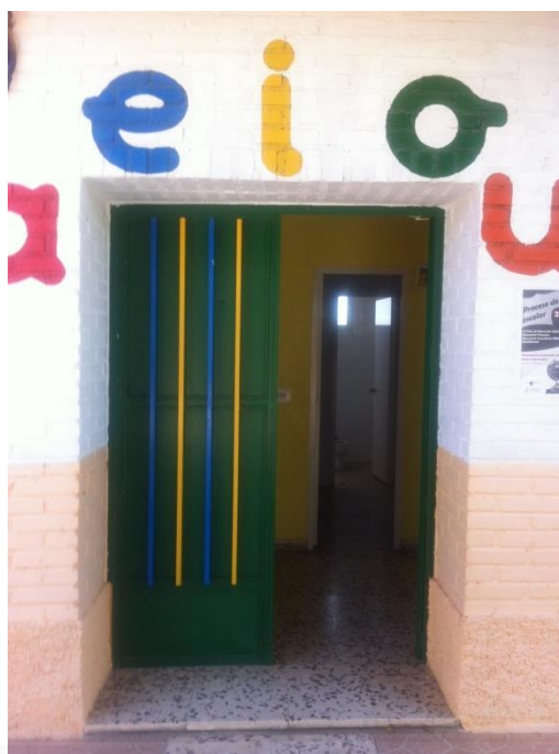
Entrada al edificio
