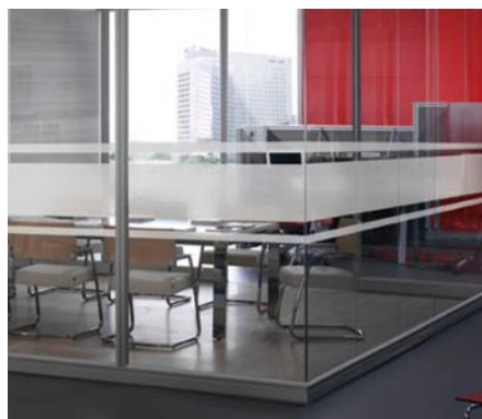
Figura 5. Tabiques acristalados señalizados
