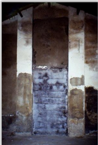
Interior del Muelle. M. Vicente. 1997.
