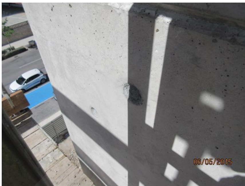
Trabajos de reparación de pantallas hormigonadas
