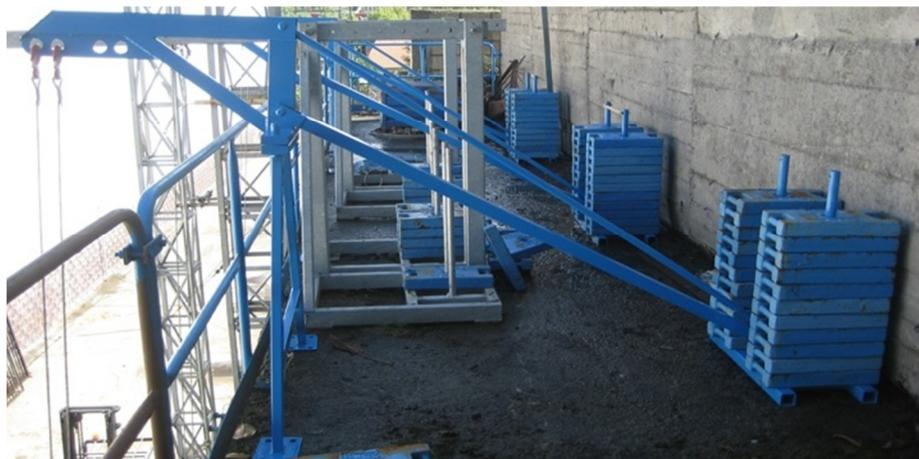
Figura 10. Detalle de lastre para plataforma suspendida.
