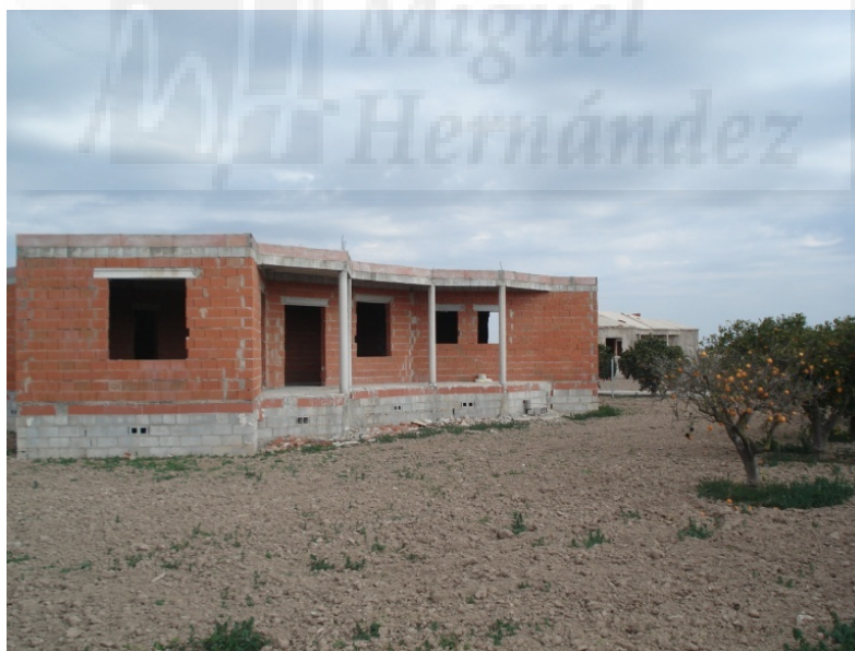
Foto nº 37.- Casas ilegales e inacabadas por la crisis en la huerta de Catral.
