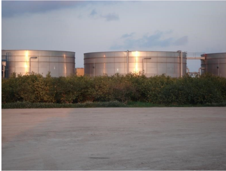
Foto nº 21.- Depuradora de Congelados Azarbe, S. A.
