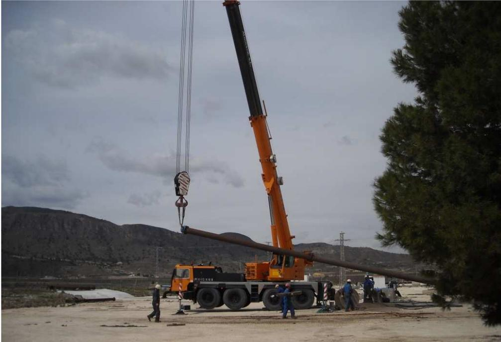
Acopio de un tramo de la columna de impulsión del pozo
