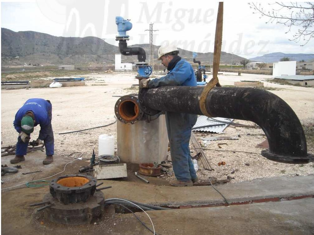
Desmontaje del brocal del pozo (2)
