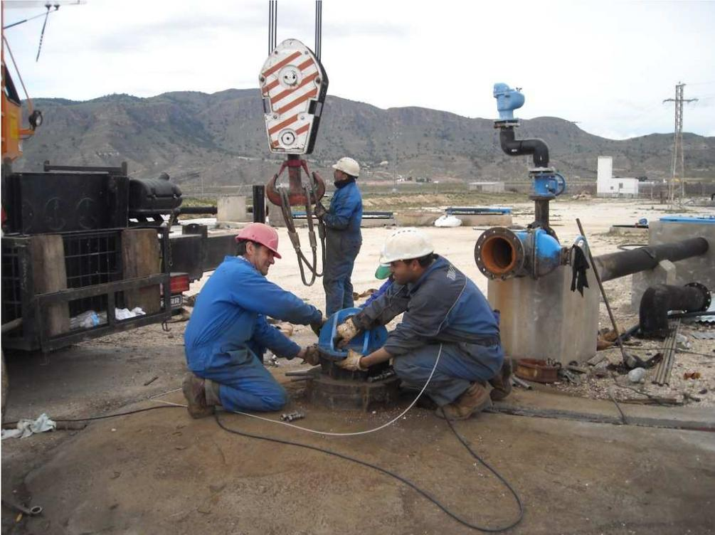
Inicio de extracción de tramos de la columna de impulsión del pozo
