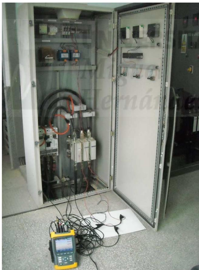
**Figura 53. Toma de datos eléctricos en el pozo P.0.0 empleado para validar el modelo**
