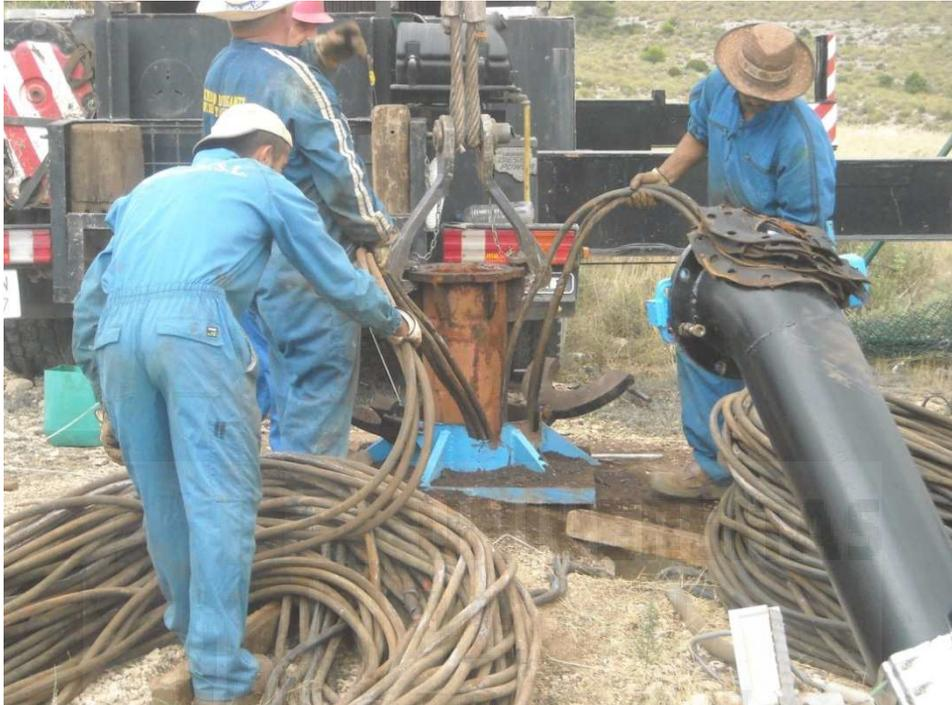
Figura 29. Extracción de un grupo motobomba en un sondeo con 9 cables
