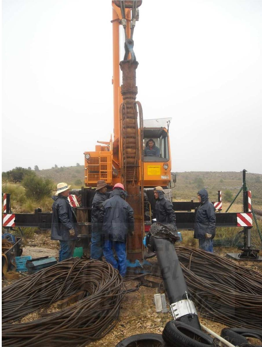
**Figura 38. Extracción de tramo de columna de impulsión solidario al grupo motobomba**
