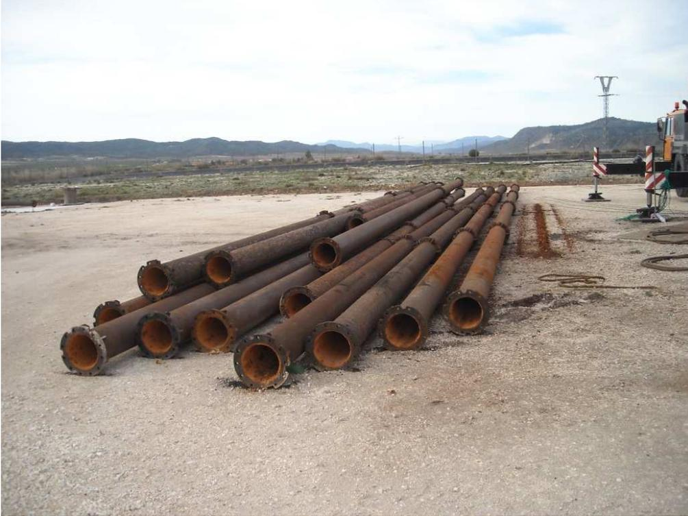
Acopio de los tramos de tubería de la columna de impulsión del pozo
