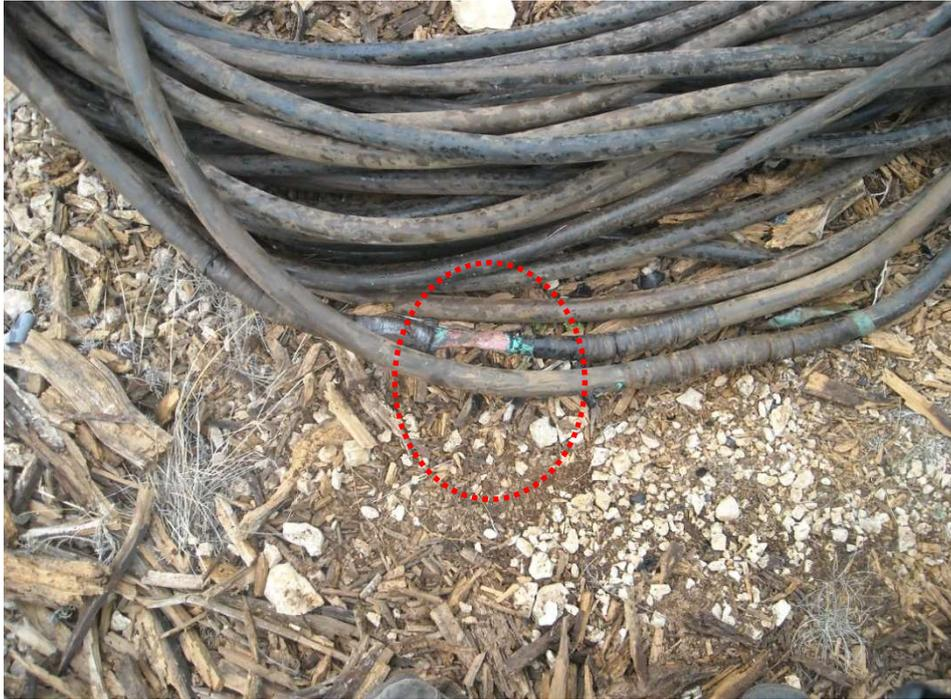
Figura 66. Instalación P.1.6. con conductor a la intemperie por excesivo calentamiento
