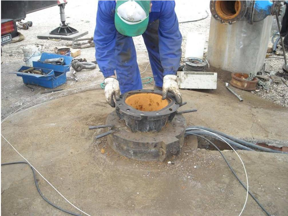
Desmontaje del brocal del pozo (3)
