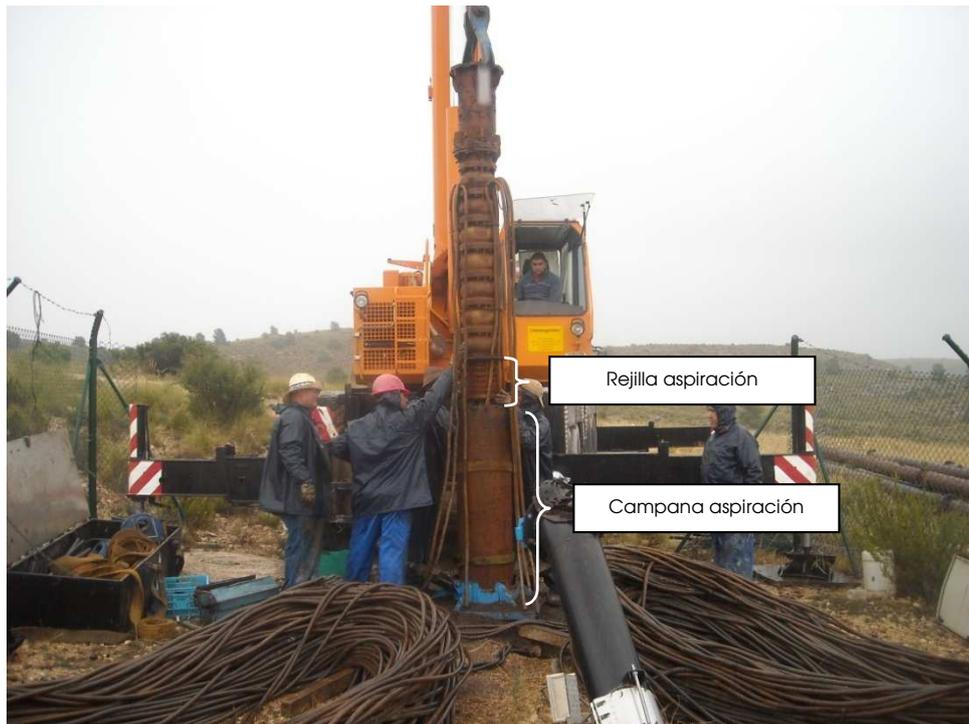
Figura 64. Extracción del sondeo 1.6., vista de la campana de aspiración para reducir los efectos de arrastre de sólidos en suspensión en las aguas
