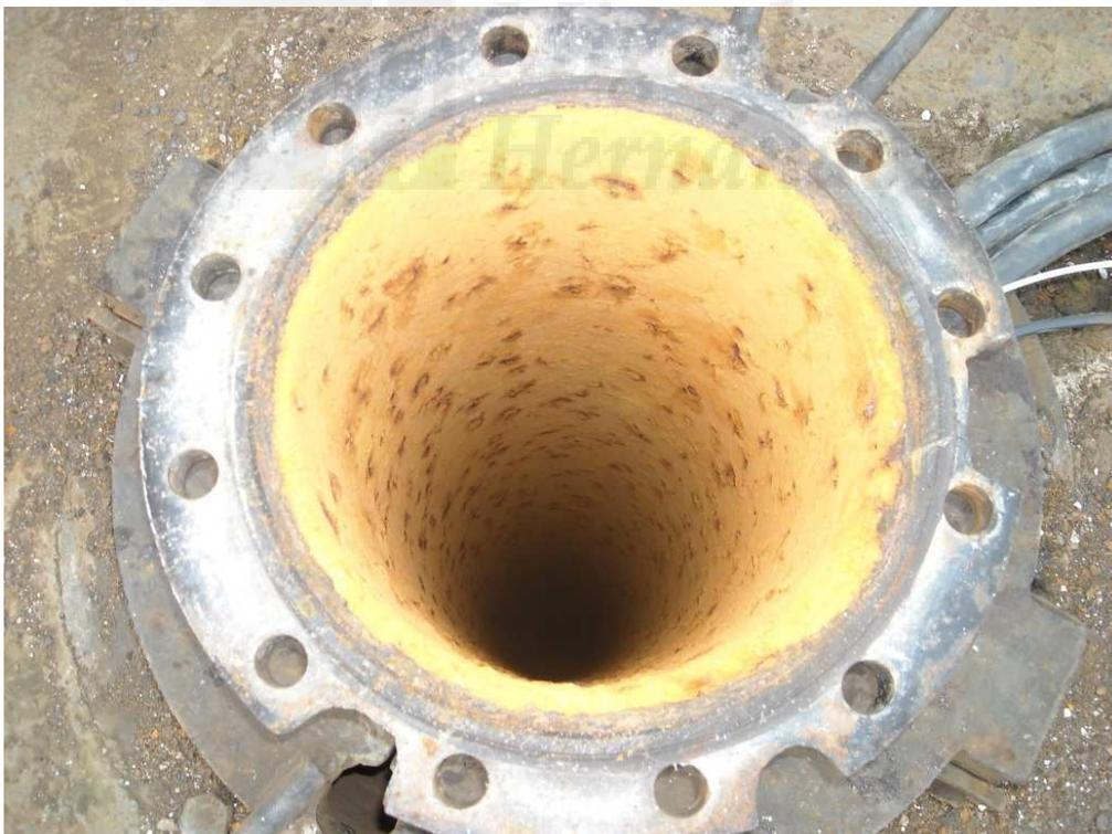
Vista interior del estado de las paredes de la columna de impulsión del pozo
