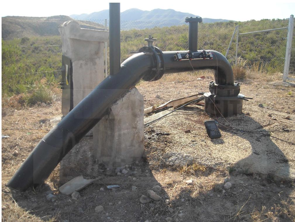
Instalación P.1.9. (La Hoya II), tomando datos de caudal mediante el caudalímetro de ultrasonidos
