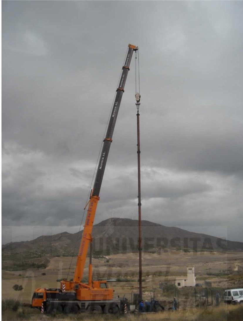
Figura 33. Grúa extrayendo la columna de impulsión de un equipo de pozo
