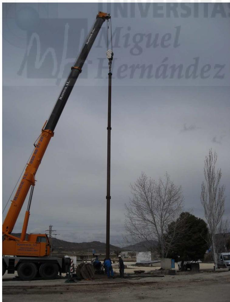
Extracción de tramos de la columna de impulsión del pozo
