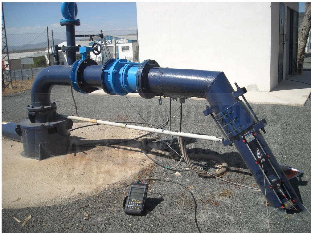
Instalación P.1.5. (Jesús II), durante la toma de datos hidráulicos mediante el caudalímetro ultrasónico y sonda de presión
