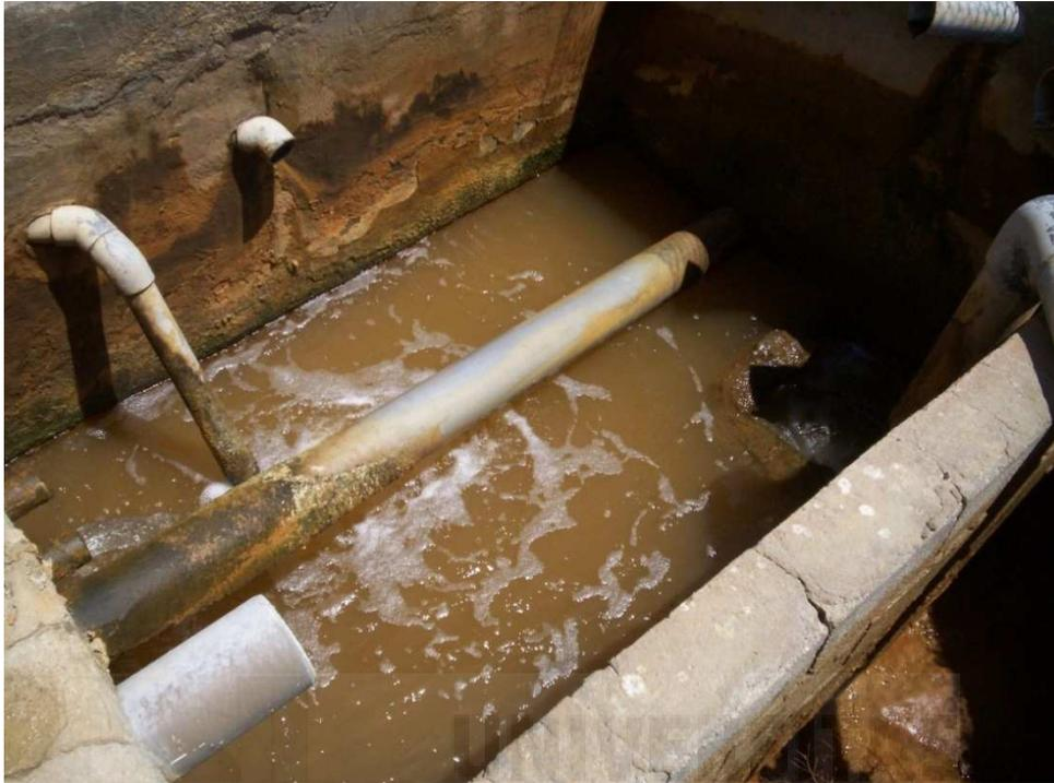
Figura 63. Agua extraída por la instalación P.3.2. con alto contenido el sólidos en suspensión
