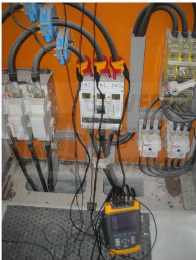
Instalación P.4.3. (Pozo 3), registrando parámetros eléctricos mediante el analizador de redes eléctricas.
