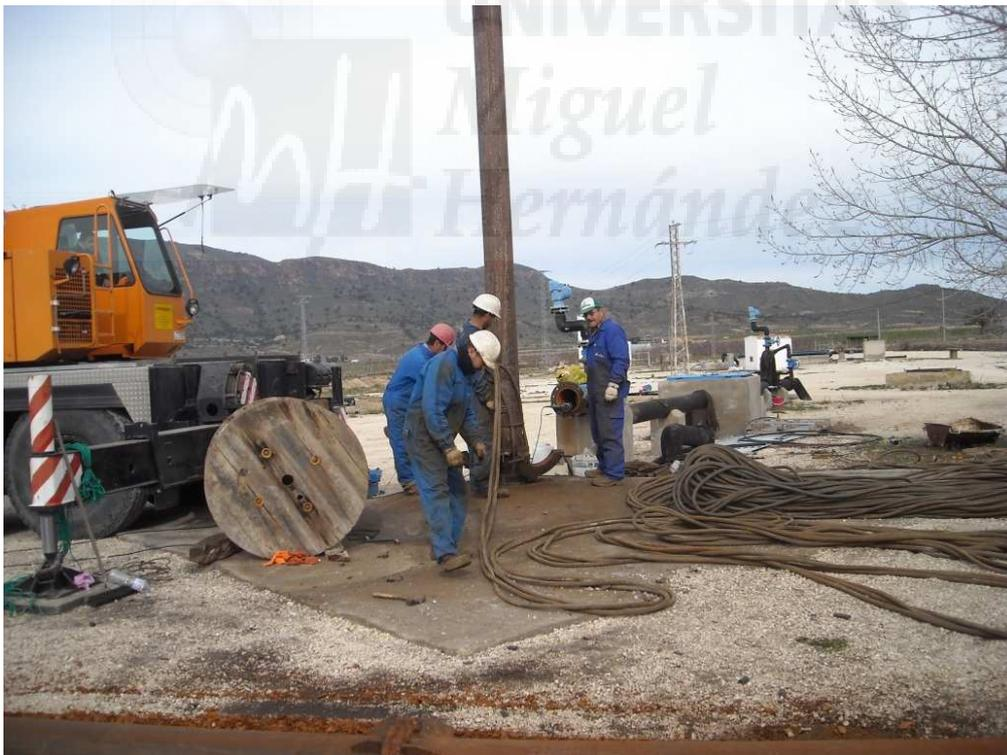
Vista del acopio de los cables adyacente al brocal del pozo
