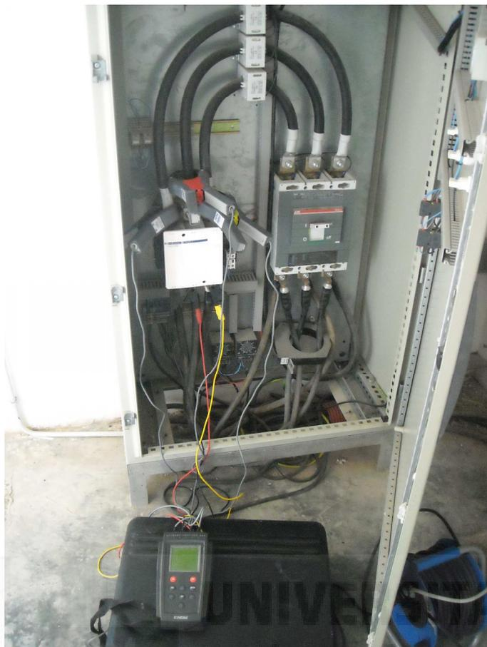
Instalación P.1.1. (Barranco), registrando parámetros eléctricos mediante el analizador de redes eléctricas
