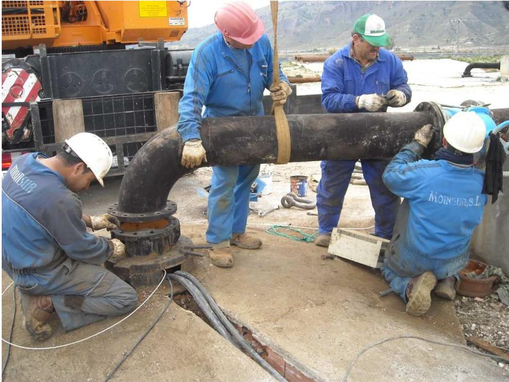
Desmontaje del brocal del pozo (1)
