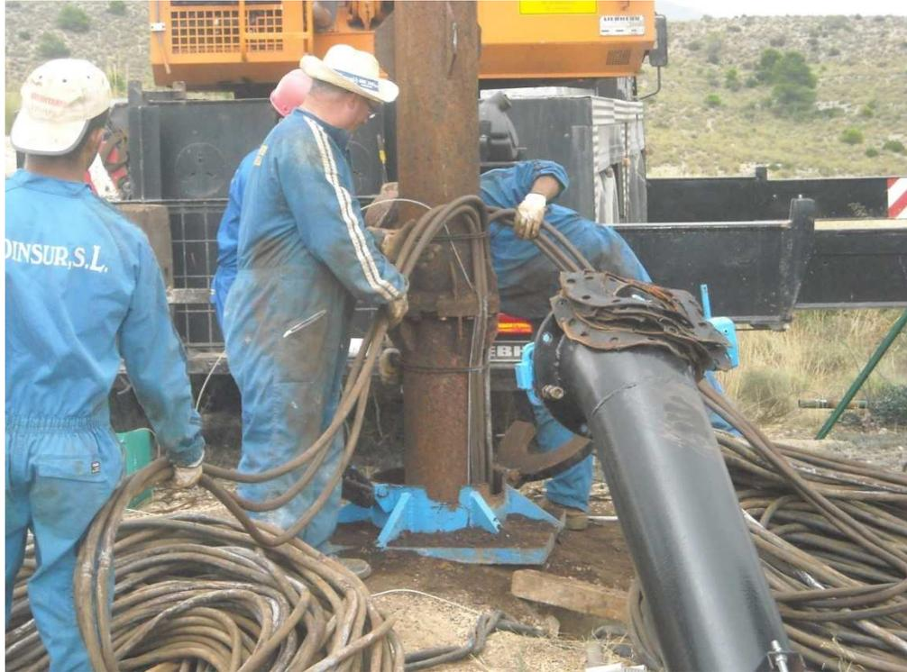
**Figura 59. Equipo de trabajo extrayendo una bomba de pozo en un momento donde se ha producido un atascamiento de la columna con la entubación del sondeo**
